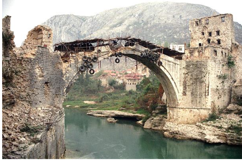
Görsel 7 Mostar Köprüsü'nün Kemerinin Gördüğü Zarar, 1993, Neretva, Bosna-Hersek. https://sarajevotimes.com/wp-content/uploads/2019/06/old-bridge-war.jpg (Erişim Tarihi: 30.10.2023).
