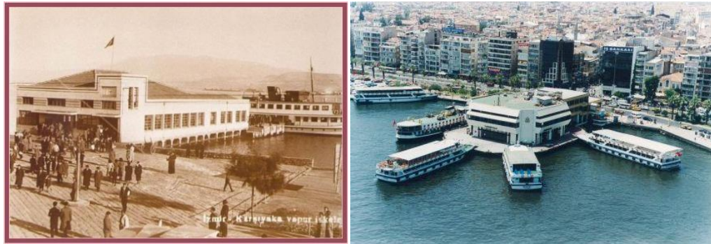
Şekil 4.4 Karşıyaka iskelesi (Soldaki betonarme ve sağdaki son hali) (İskele2, İskele3, 2015)
