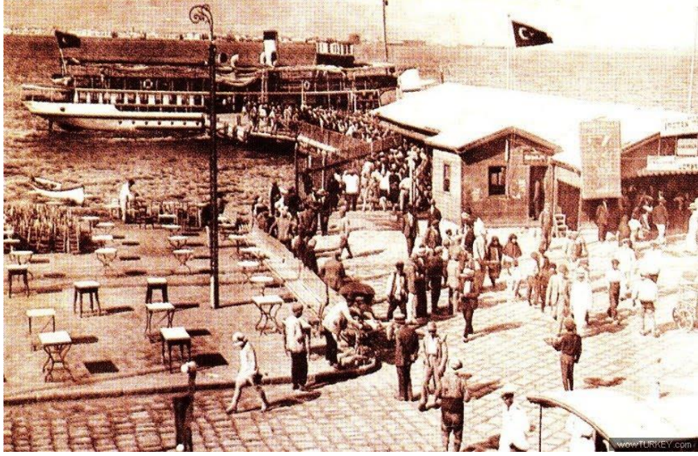
Şekil 4.3 Karşıyaka iskelesi (Ahşap) (İskele1, 2015)
