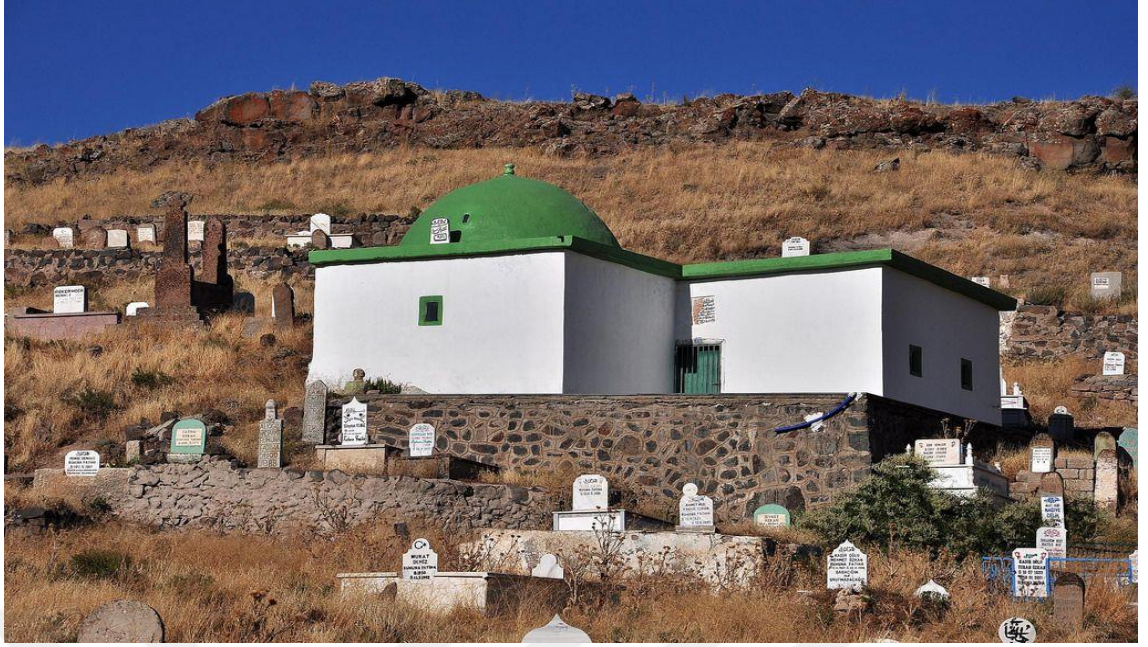
Resim-13: Ebce Sultan Zâviyesi/Kayseri
