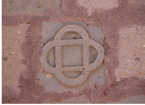
Resim 60: Şeyh Turesan Zaviyesi Mescidin Doğu Cephesindeki Süsleme
