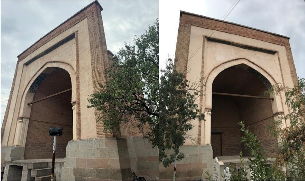
Resim 96: Gömeç Hatun Türbesinin Kuzey Cepheden Görünümü
