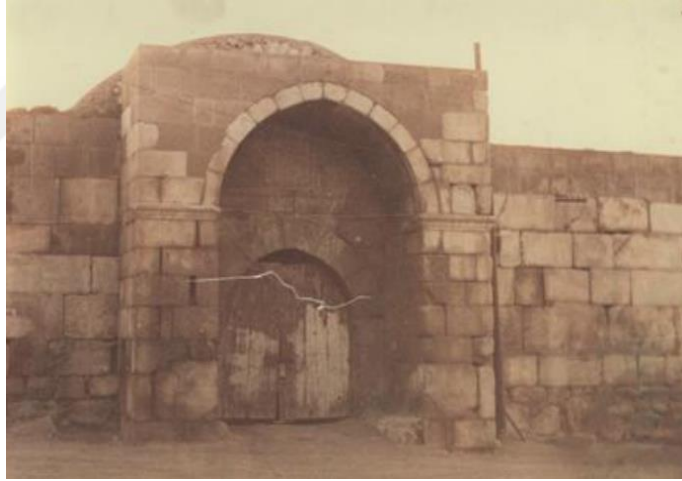
Resim 39: Kadınhanı’nın Batı Cepheden (Giriş) Görünümü
