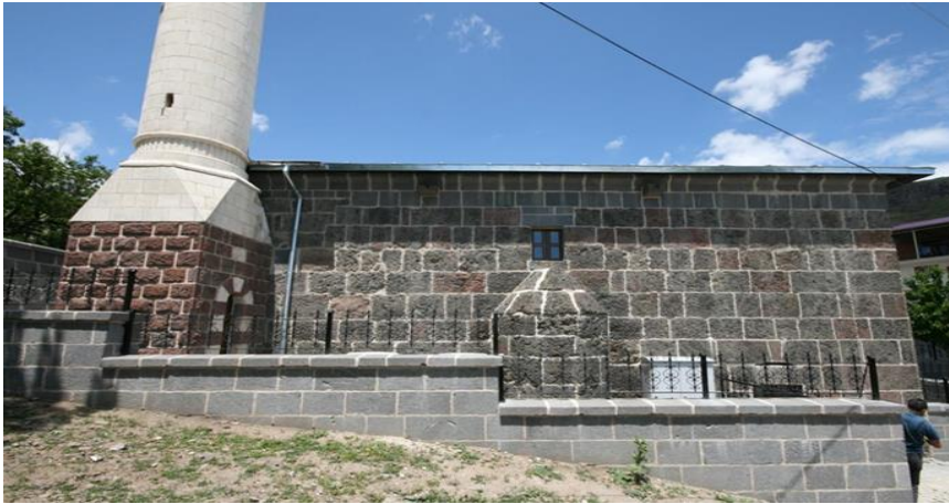
Resim 29: Mazgirt Elti Hatun Camisi Güney Cephe
