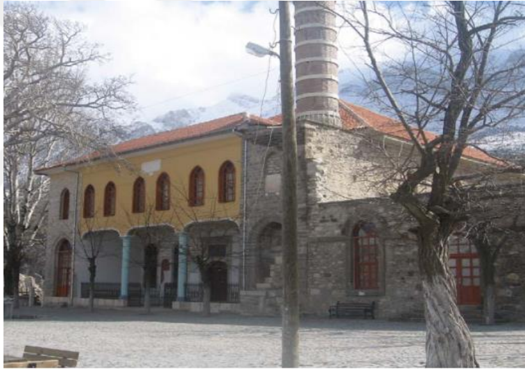
Resim 43: Uluborlu Alaaddin Camiinin Kuzey Cephesinden Genel Görünümü
