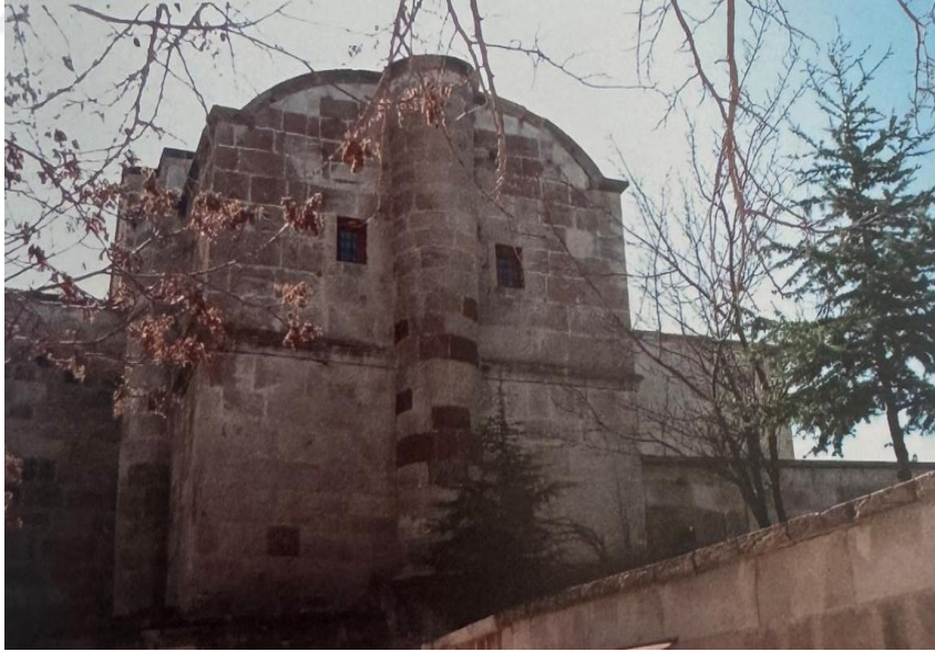
Resim 24: Ümmühan Hatun Türbesi Kuzey Cephe
