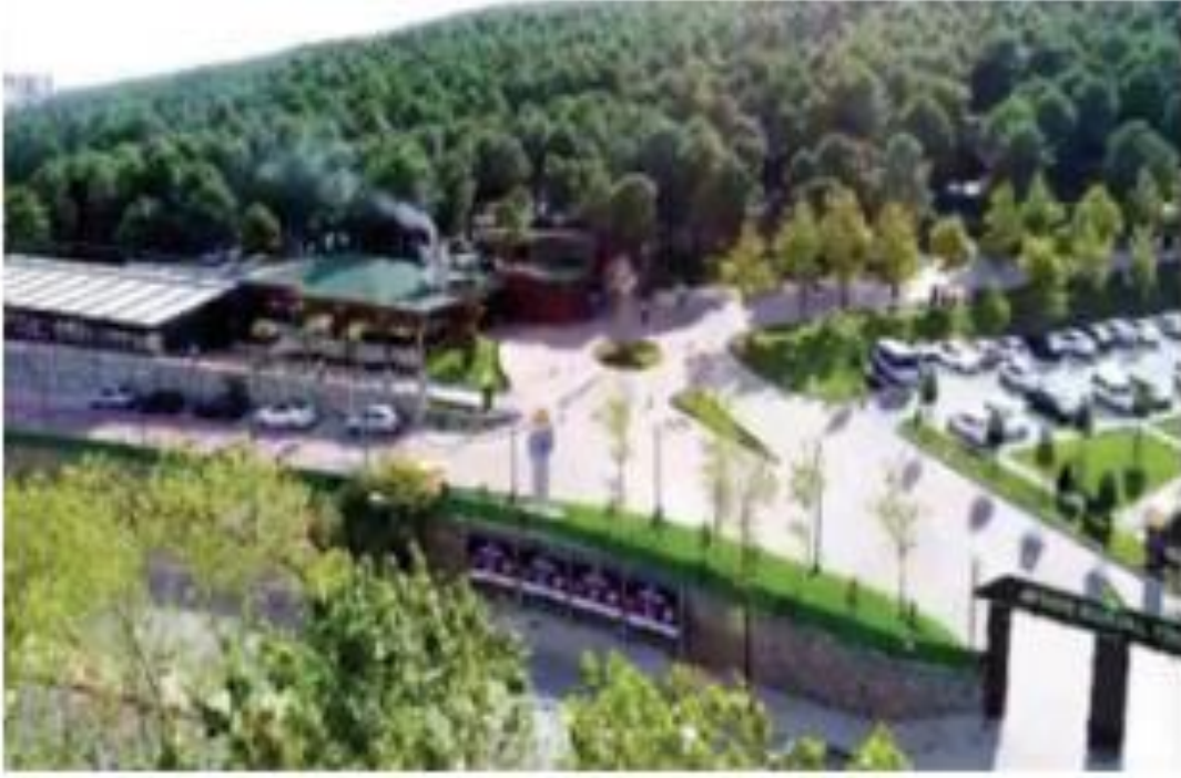
Görsel 3. Sultanbeyli Belediyesi Aydos Sosyal Tesisleri Üst Görünüm
