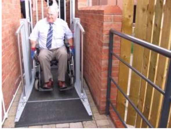
Şekil 4. 20 Premier Inn Chester rampa uygulaması [96]
