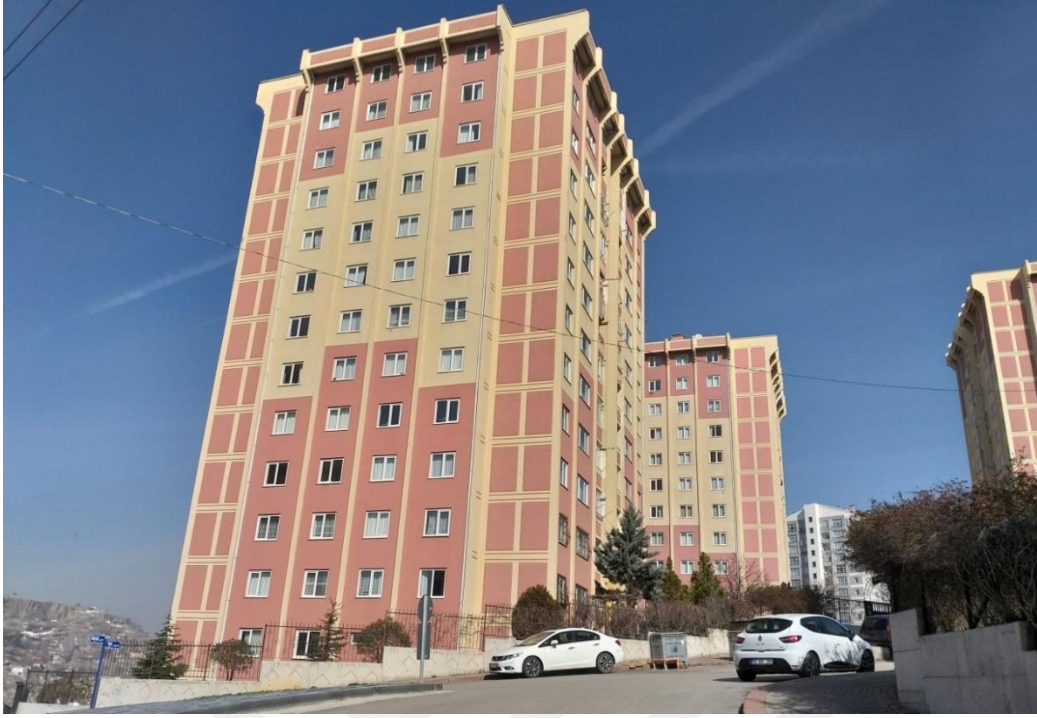
Resim 7.3. Aktaş Mahallesi kentsel dönüşüm projesi I.etap konutları
