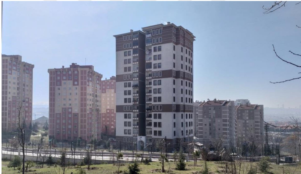
Resim 7.7. Aktaş Mahallesi kentsel dönüşüm projesi 3. etap konutları
