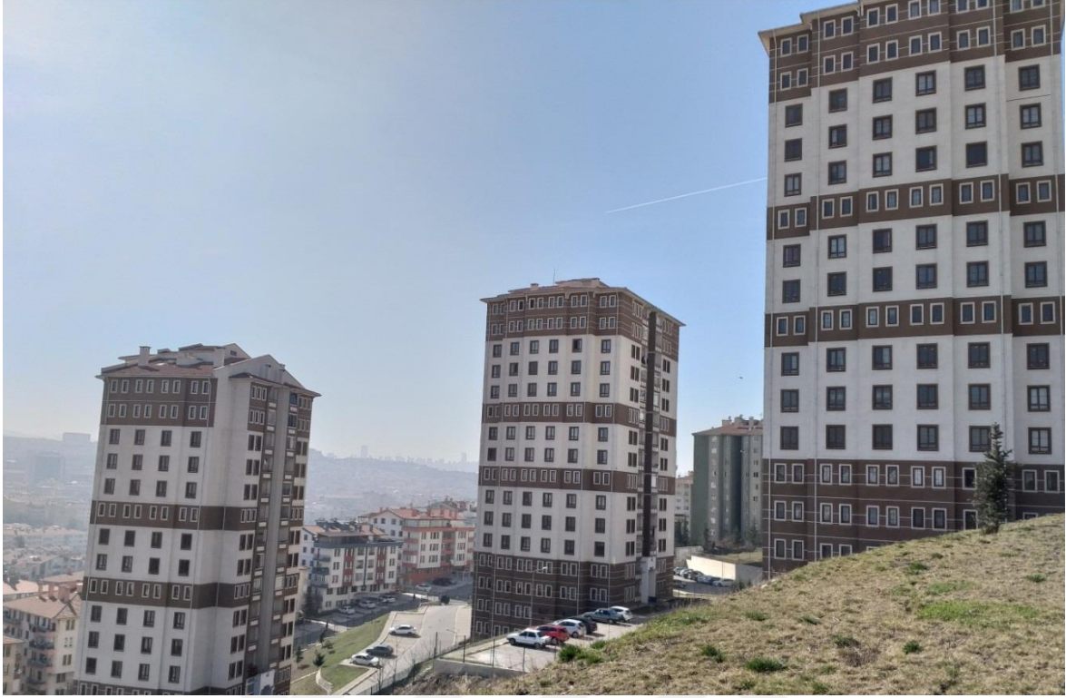
Resim 7.8. Aktaş Mahallesi kentsel dönüşüm projesi 3. etap konutları
