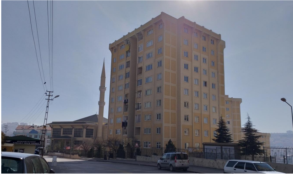
Resim 7.2. Aktaş Mahallesi kentsel dönüşüm projesi I.etap konutları
