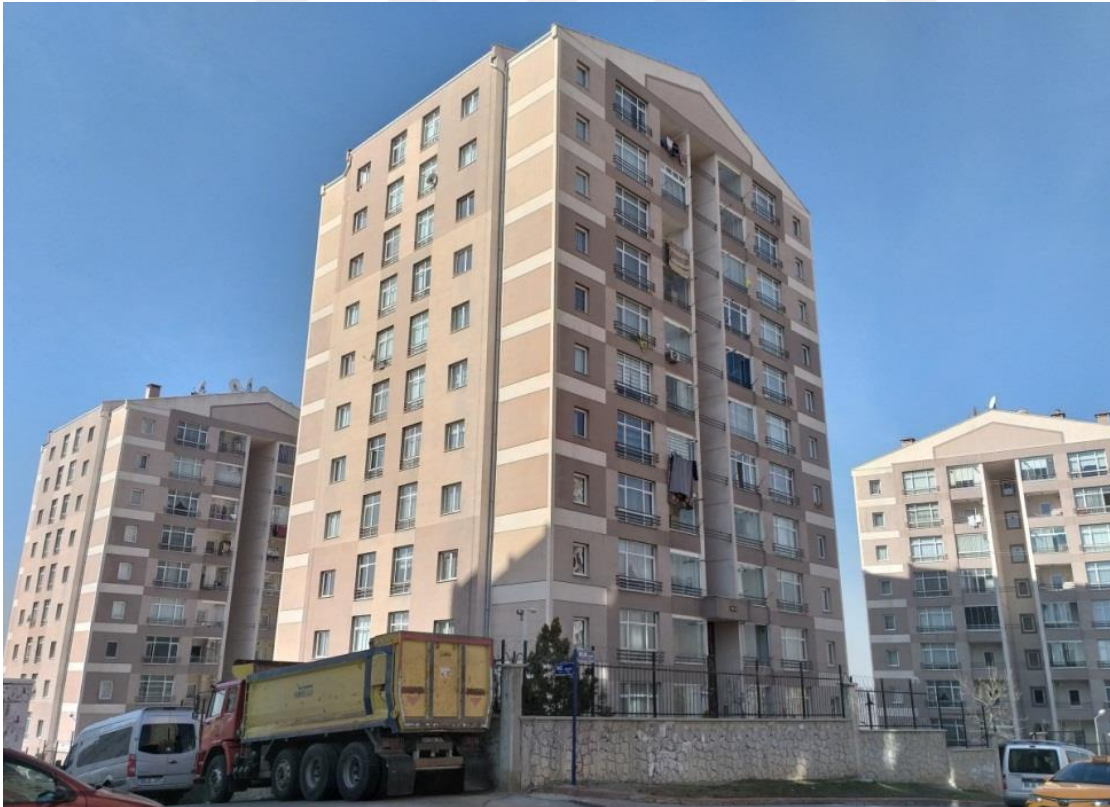
Resim 7.6. Aktaş Mahallesi kentsel dönüşüm projesi 2. etap konutları
