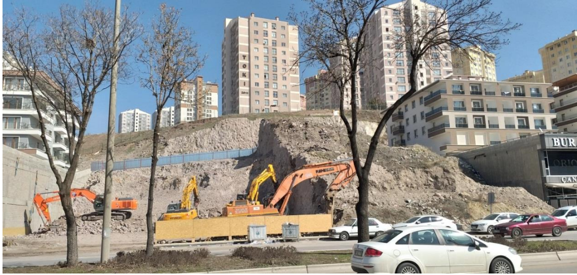
Resim 7.12. Devam eden inşaat çalışmaları
