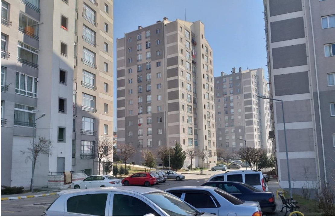
Resim 7.5. Aktaş Mahallesi kentsel dönüşüm projesi 2. etap konutları
