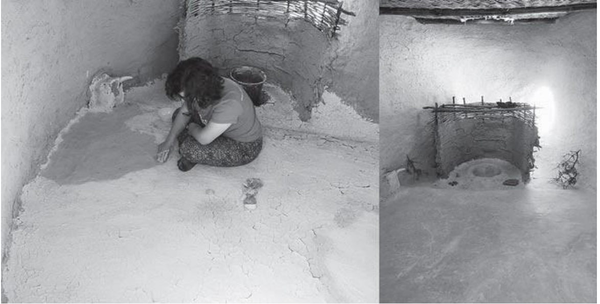
Resim 2.8. Taban Sıvası Üzerinde Perdahlama Tekniğinin Kullanımı.
