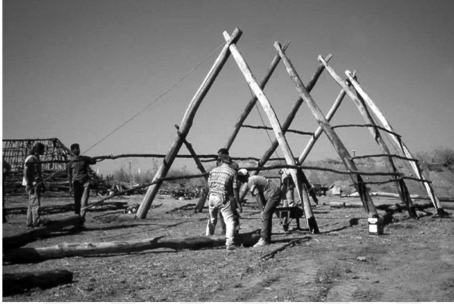
Resim 2.17. Ahmetler Köyü’nden gelen samanlığın Açık hava müzesi alanına getirilip kurulması
