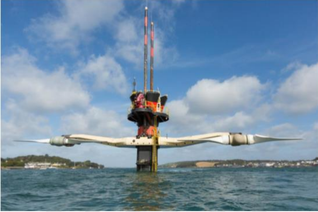
řekil 8. 1.2 MW ift kanatlı yatay eksen kurulu akıntı trbini (Uřar, 2015)
