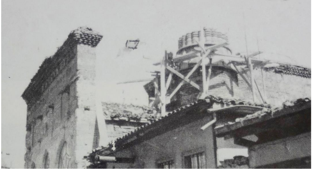
Şekil 7.48: Ahmet Dai Camii onarım sırasındaki durumu. (Bursa Eski Eserleri Sevenler Kurumu Hizmet Albümü, 1985)
