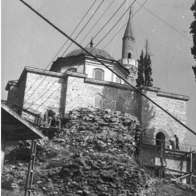
řekil 7.81:  ftade Camii onarım sonrası durumu. (Bursa Eski Eserleri Sevenler Kurumu Hizmet Alb m , 1985)
