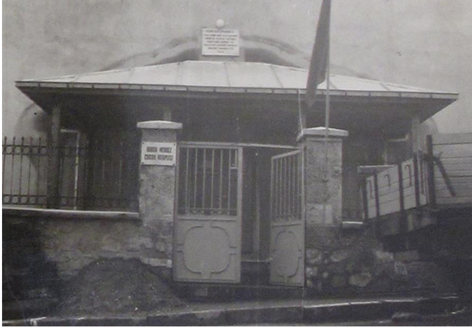
Şekil 7.76: Lalaşahin Paşa Medresesi onarım sonrası durumu. (Bursa Eski Eserleri Sevenler Kurumu Hizmet Albümü, 1985)
