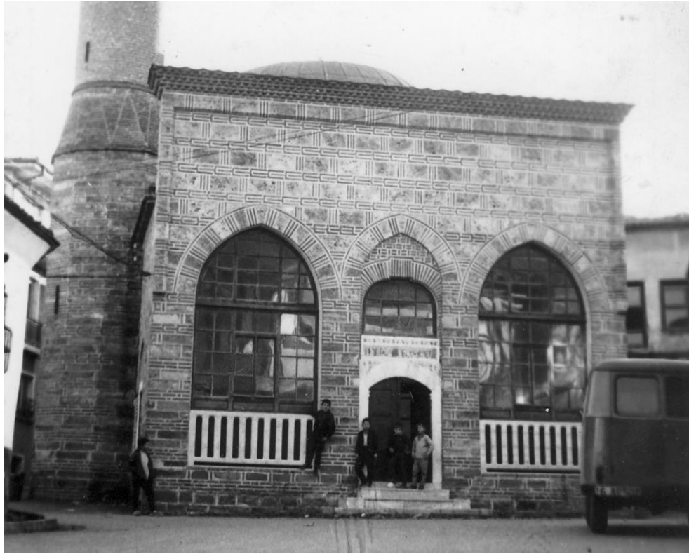
Şekil 7.58: Nalbantoğlu Camii onarım sonrası durumu. (Bursa Eski Eserleri Sevenler Kurumu, 1985)
