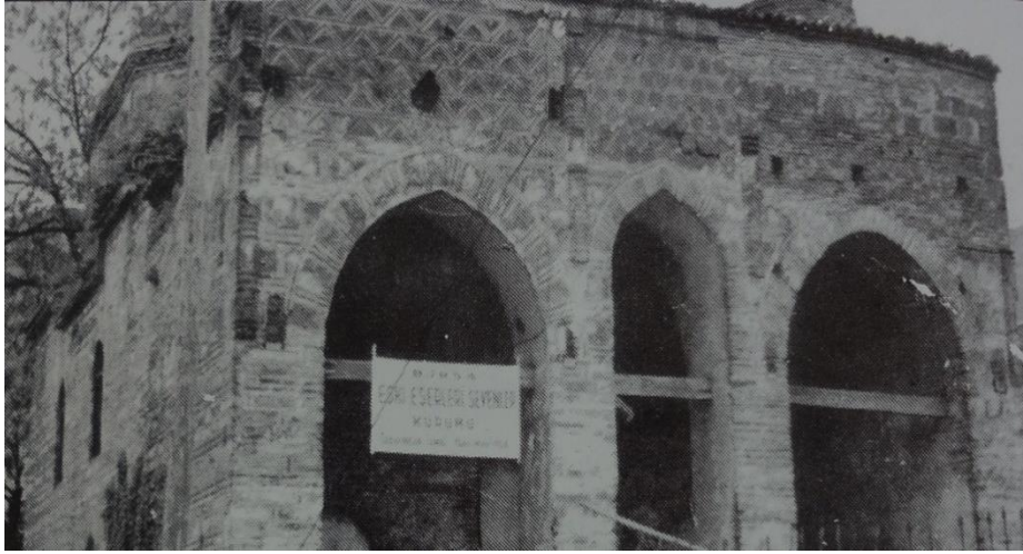
Şekil 7.36: Bedrettin Camii onarım öncesi cephesi. (Bursa Eski Eserleri Sevenler Kurumu Hizmet Albümü, 1985)
