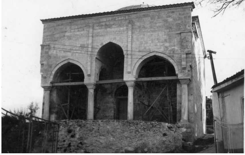
Şekil 7.68: Hatice Sultan Türbesi onarım sonrası durumu. (Bursa Eski Eserleri Sevenler Kurumu Hizmet Albümü, 1985)
