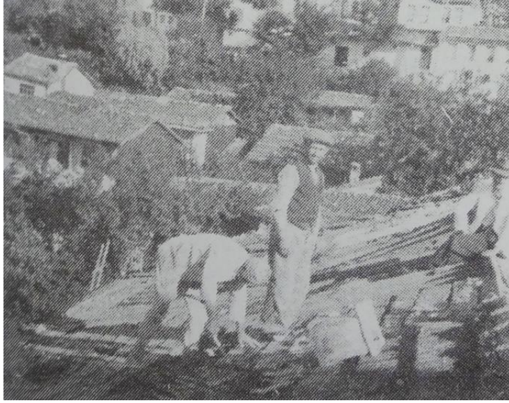
Şekil 7.26: Molla Arap Camii onarımı sırasında çatı üzerinde Rıza İlova çalışırken. (Bursa Eski Eserleri Sevenler Kurumu Hizmet Albümü, 1985)
