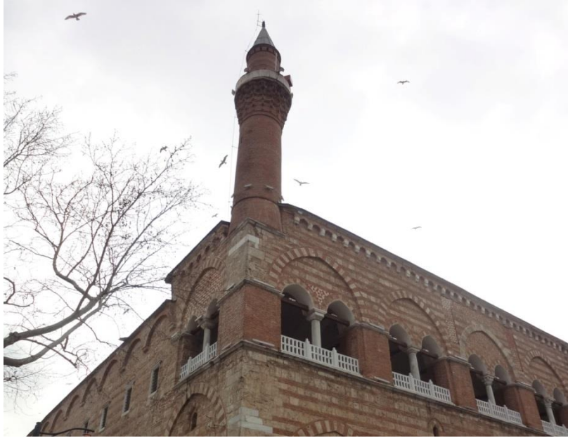
řekil 7.66: Hdavendigar Camii minaresi gnmzdeki durumu. (Keskin, 2014)
