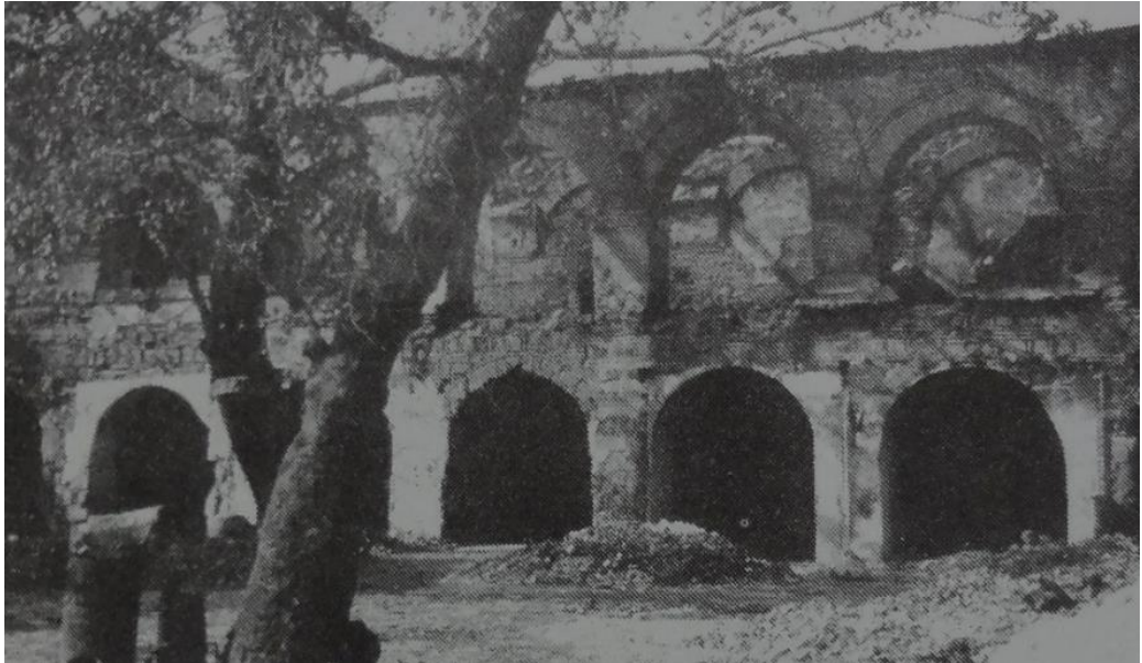
Şekil 7.19: Fidan Hanı onarım öncesi durumu. (Bursa Eski Eserleri Sevenler Kurumu Hizmet Albümü, 1985)
