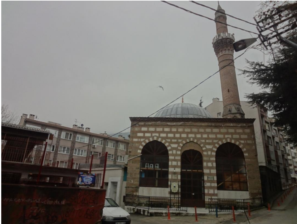
Şekil 7.30: Hocaalizade Camii günümüzdeki durumu. (Keskin, 2014)
