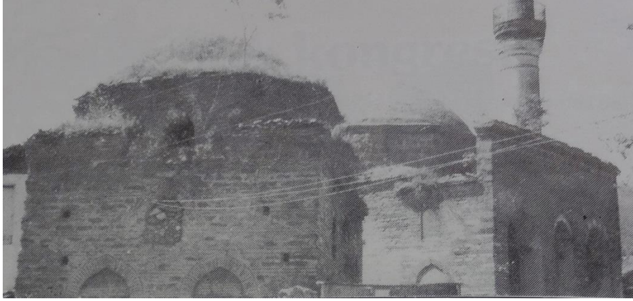
Şekil 7.40: Kanberler Camii onarım öncesi durumu. (Bursa Eski Eserleri Sevenler Kurumu Hizmet Albümü, 1985)
