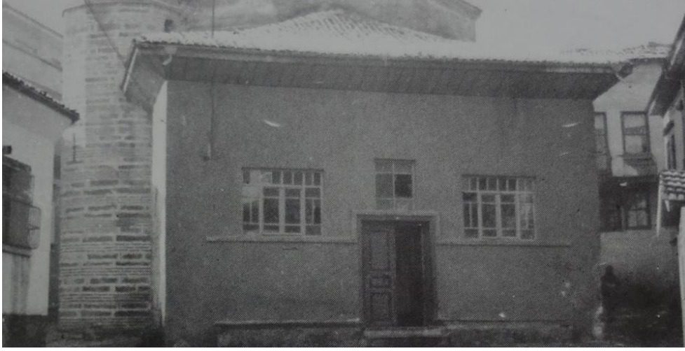
Şekil 7.57: Nalbantoğlu Camii onarım öncesi durumu. (Bursa Eski Eserleri Sevenler Kurumu Hizmet Albümü, 1985)
