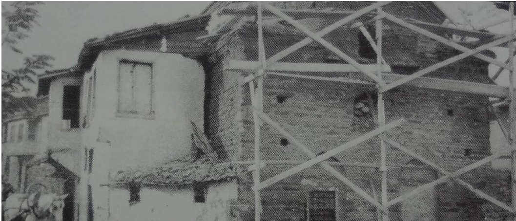
Şekil 7.9: Kanberler Muallimhanesi onarım sırasındaki durumu. (Bursa Eski Eserleri Sevenler Kurumu Hizmet Albümü, 1985)
