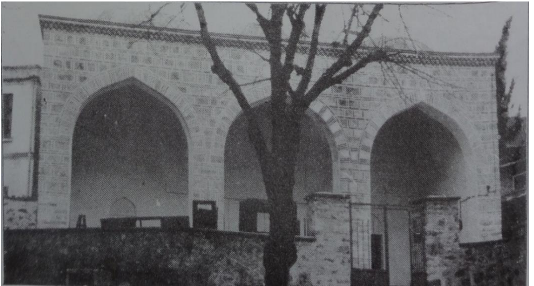
Şekil 7.32: Abdal Camii onarım sonrası durumu. (Bursa Eski Eserleri Sevenler Kurumu Hizmet Albümü, 1985)
