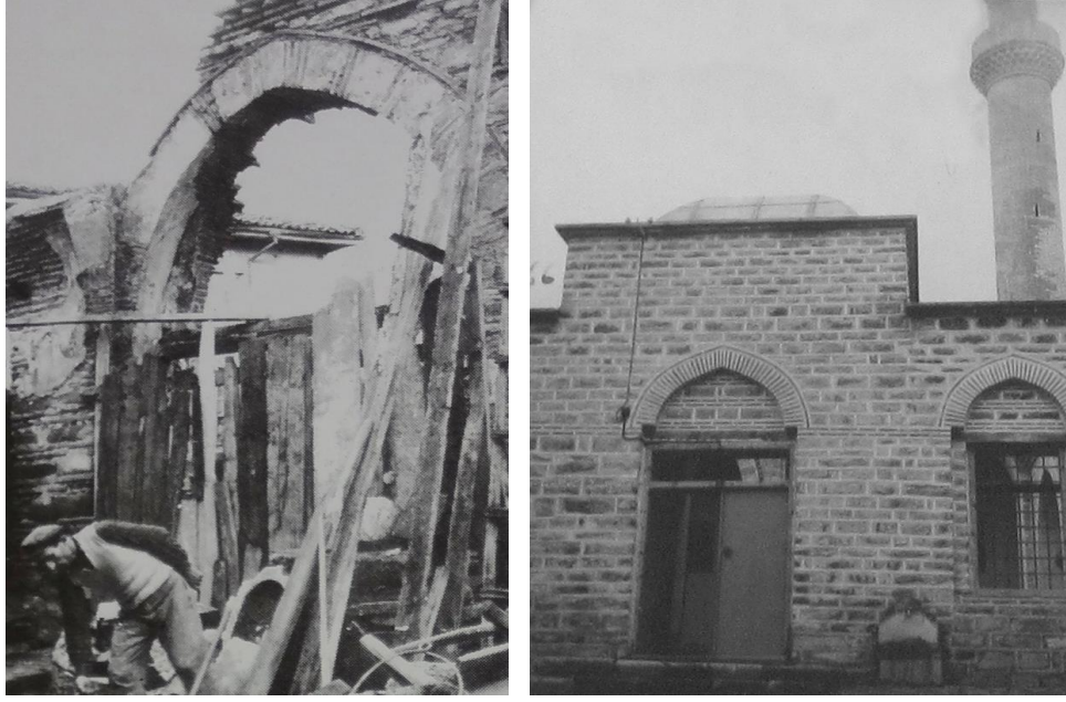
Şekil 7.73: Soldaki görselde Başçı İbrahim Camii'nin onarım sırasındaki durumu, sağdaki görselde ise Cami'nin onarım sonrası durumu görülmektedir. (Bursa Eski Eserleri Sevenler Kurumu, 1985)
