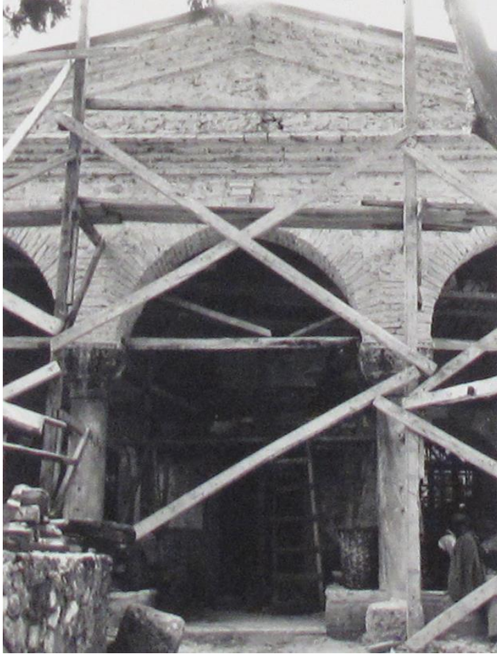
Şekil 7.70: Alâüddin Camii onarım sırasındaki durumu. (Bursa Eski Eserleri Sevenler Kurumu Hizmet Albümü, 1985)
