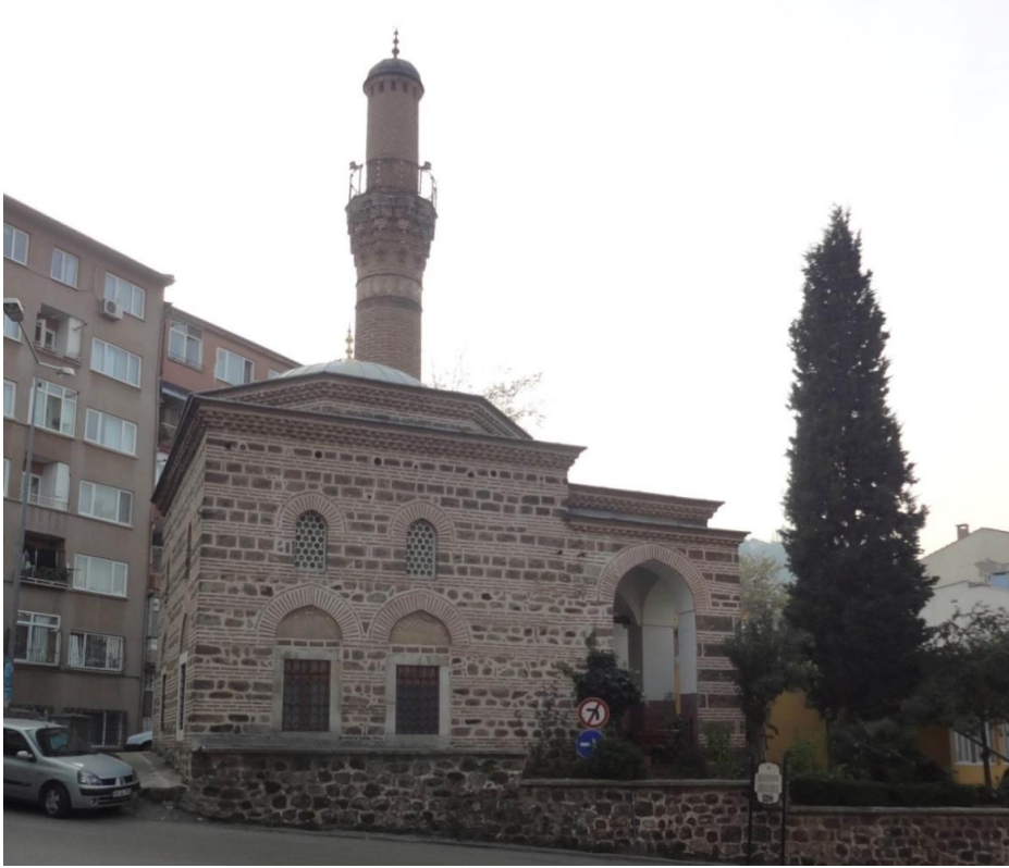
Şekil 7.47: Beşikçiler Camii günümüzdeki durumu. (Keskin, 2014)
