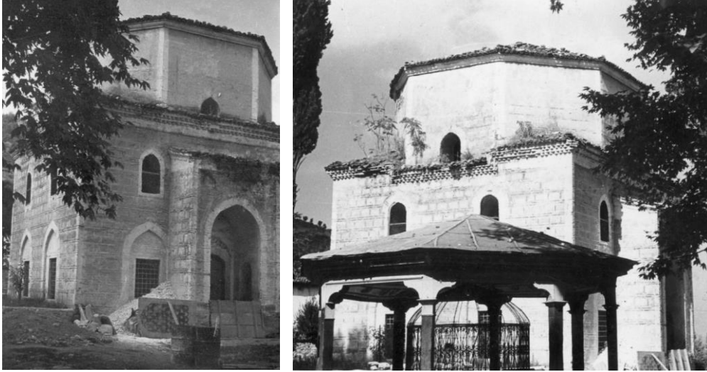
Şekil 7.63: Kara Mustafa Paşa Türbesi onarım öncesi durumu. (Bursa Eski Eserleri Sevenler Kurumu Hizmet Albümü. 1985)
