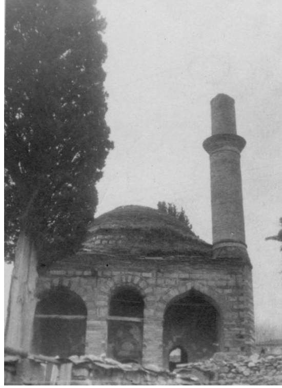
Şekil 7.50: Zeyniler Camii onarım öncesi durumu. (Bursa Eski Eserleri Sevenler Kurumu Hizmet Albümü, 1985)
