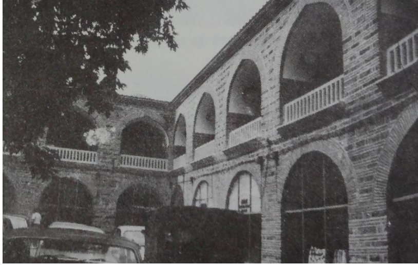
Şekil 7.20: Fidan Hanı onarım sonrası durumu. (Bursa Eski Eserleri Sevenler Kurumu Hizmet Albümü, 1985)
