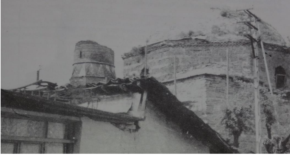
Şekil 7.35: Bedrettin Camii onarım öncesi durumu. (Bursa Eski Eserleri Sevenler Kurumu Hizmet Albümü, 1985)
