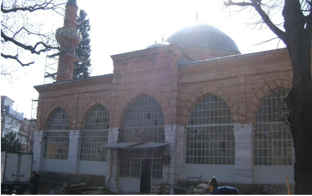
Şekil 7.55: Hamzabey Camii Bursa Vakıflar Bölge Müdürlüğü onarımı sırasındaki durumu. (Bursa Vakıflar Bölge Müdürlüğü Yatırım Programı Dosyası)
