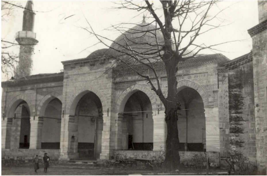
Şekil 7.54: Hamzabey Camii onarım sonrası durumu. (Bursa Eski Eserleri Sevenler Kurumu Hizmet Albümü, 1985)
