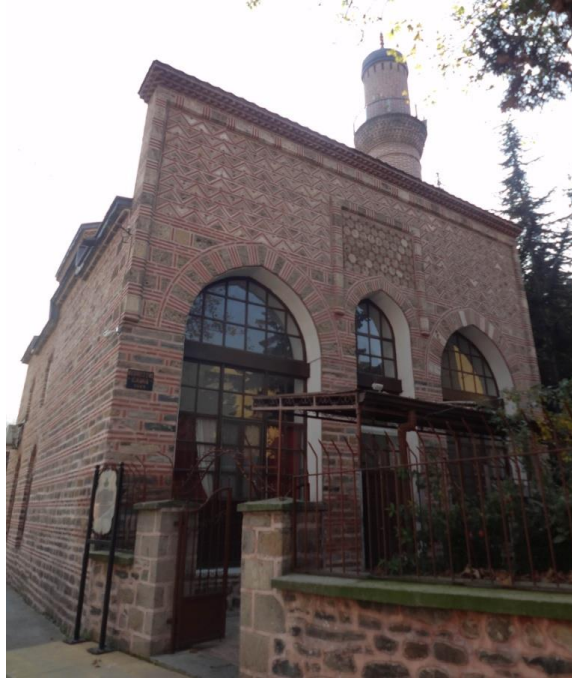
Şekil 7.39: Bedrettin Camii günümüzdeki durumu. (Keskin, 2014)
