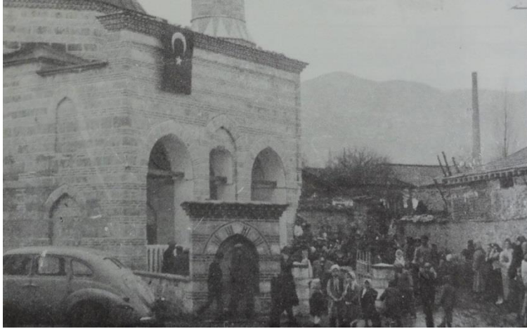
Şekil 7.61: Acem Reis Camii onarım sonrası durumu. (Bursa Eski Eserleri Sevenler Kurumu Hizmet Albümü, 1985)
