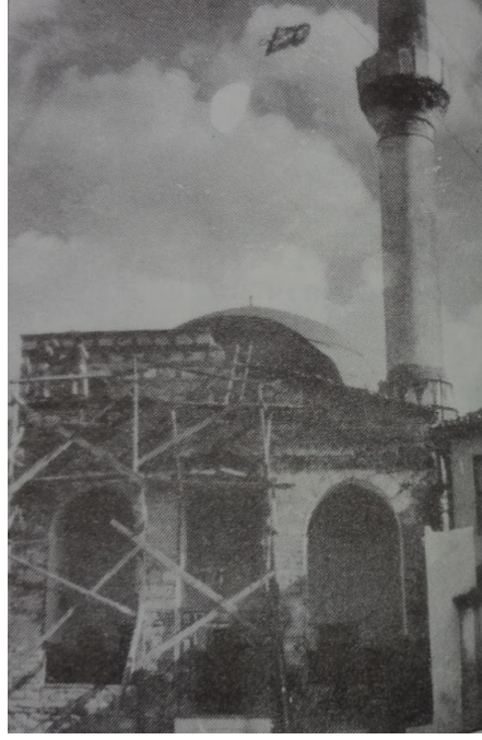
Şekil 7.23: Hacılar Camii onarım sırasındaki durumu. (Bursa Eski Eserleri Sevenler Kurumu Hizmet Albümü, 1985)
