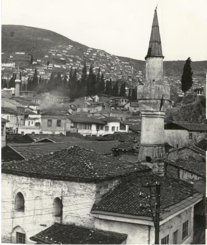
Şekil 7.86: Mecnun Dede Camii onarım öncesi durumu. (Bursa Eski Eserleri Sevenler Kurumu Hizmet Albümü, 1985)
