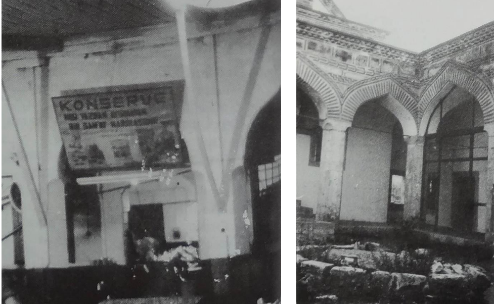
Şekil 7.14: Soldaki görselde konserve fabrikası olarak kullanılan İnebey Medresesi'nin tahliye sonrası durumu, sağdaki görselde ise Medrese'nin onarım sonrası durumu görülmektedir. (Bursa Eski Eserleri Sevenler Kurumu Hizmet Albümü, 1985)
