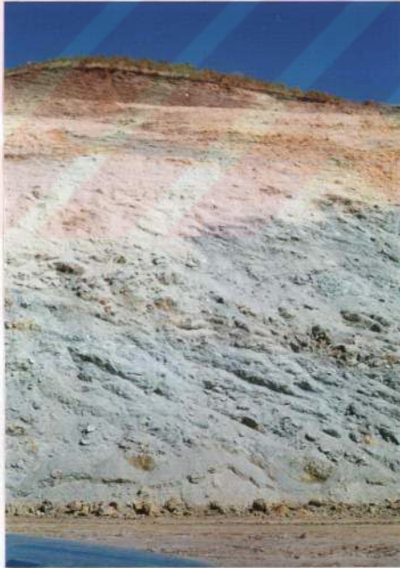
Şekil 2.12: Karataş Mevki'nde yol yarmasında andezitik ve bazaltik birim içinde görülen alterasyon. Üstte oksitli zon, ortada sulfürlü zon, altta ise ana kaya bulunmaktadır. Kuzeye bakış.
