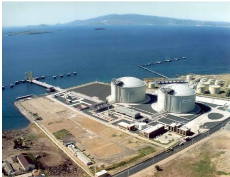
Şekil 2.4: Egegaz LNG depolama tesisleri (URL-1).
