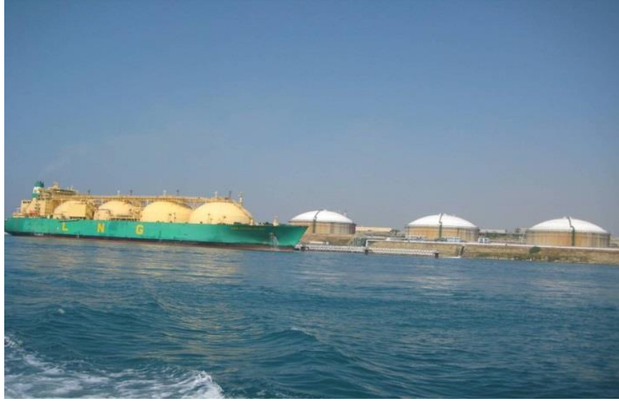
Şekil 2.3: Marmara Ereğlisi (LNG) depolama tesisleri (URL-1).
