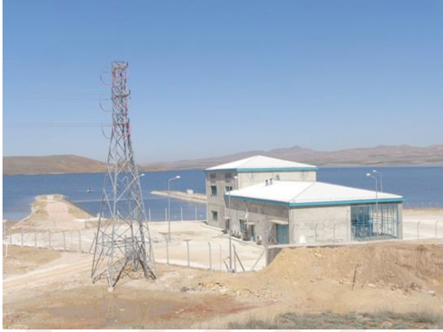
Şekil 2.23. Hirfanlı Barajı su alma yapısı (Bektaşoğlu, 2016).
