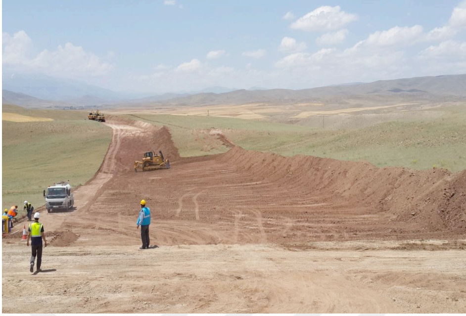
Şekil 4.1. Üst toprak sıyırılmış çalışma koridoru (URL-20).
