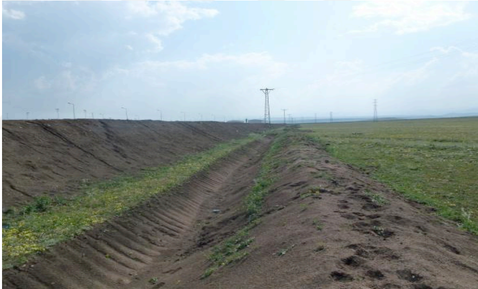
Şekil 4.4. Üst toprak depolamada drenaj kanalları açılması (URL-20).
