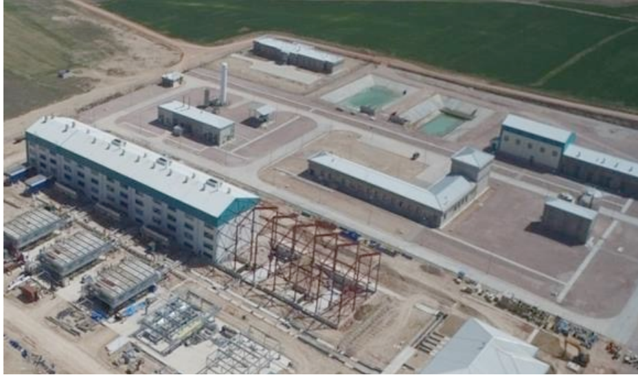
Şekil 2.28. Yüzey tesisleri inşasına dair görsel (Bektaşoğlu, 2016).
