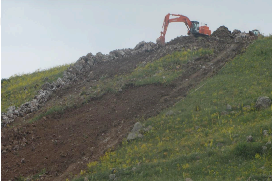
Şekil 4.2. Taşlık alanda yapılan toprak sıyırma çalışmaları (URL-20).
