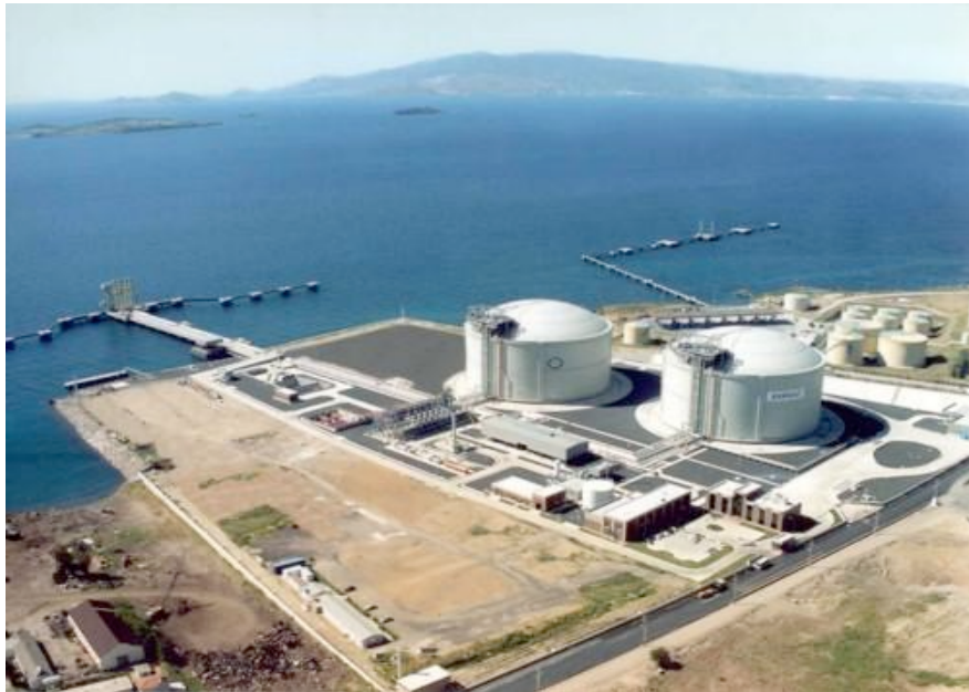
Şekil 2.19. Egegaz depolama tesisine ait görsel (Bektaşoğlu, 2016).
