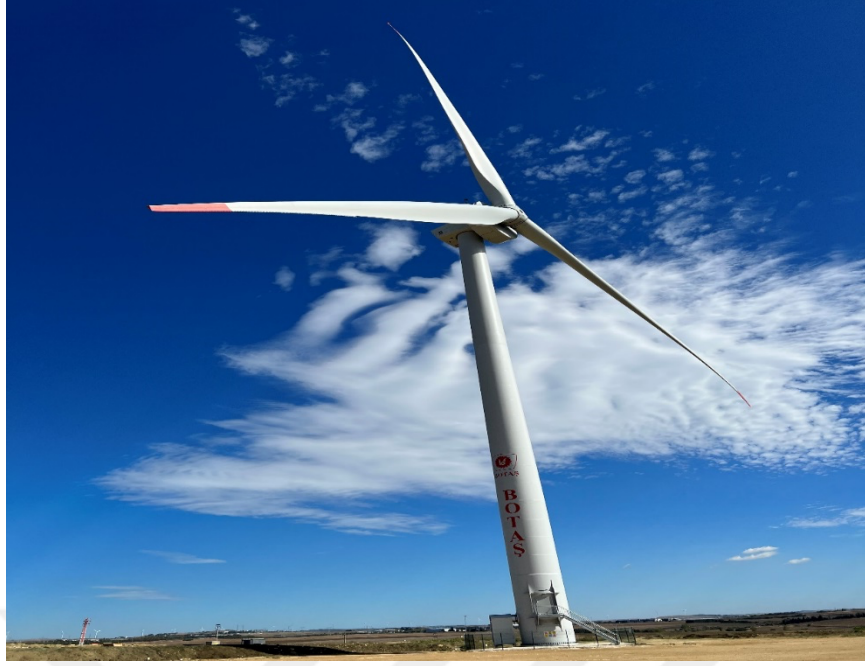
Şekil 2.17. Silivri doğal gaz depolama tesisi rüzgar enerjisi santrali (URL-21).
