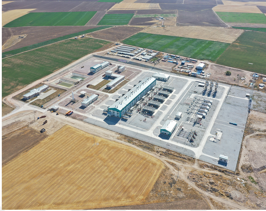
Şekil 2.18. Tuz Gölü doğal gaz depolama tesisine ait görsel (URL-21).
