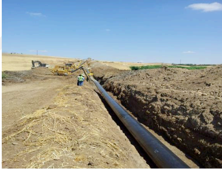
Şekil 2.24. Su temin hattı inşaatı (Bektaşoğlu, 2016).
