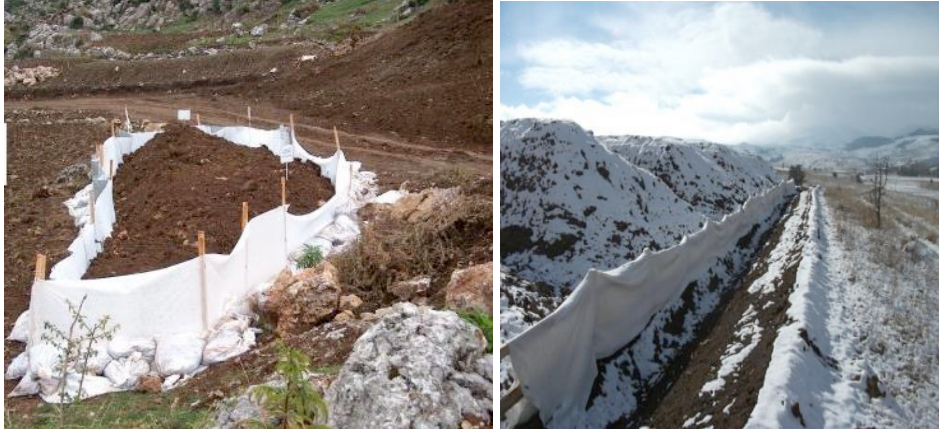
Şekil 4.3. Alt ve üst toprağın karışımını engellemek amacı ile yapılan örnek çalışmalar (Silt kafes uygulamaları) (URL-20).
