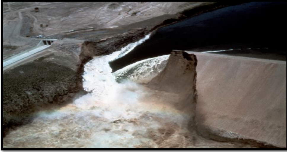
Şekil 1.34. Teton Barajı yıkılma anı (1976)
