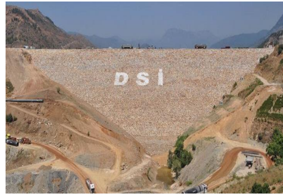
Şekil 1.8(b). Alaköprü Barajı gövdesi (Mersin)
