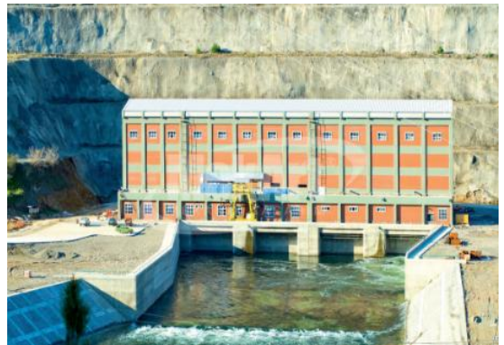
Şekil 1.15(b). Obruk Barajı santral binası (Çorum)
