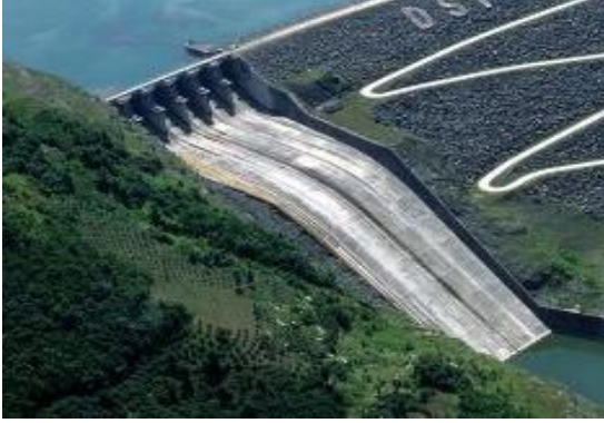
Şekil 1.12(a). Hasan Uğurlu Barajı (Samsun)
