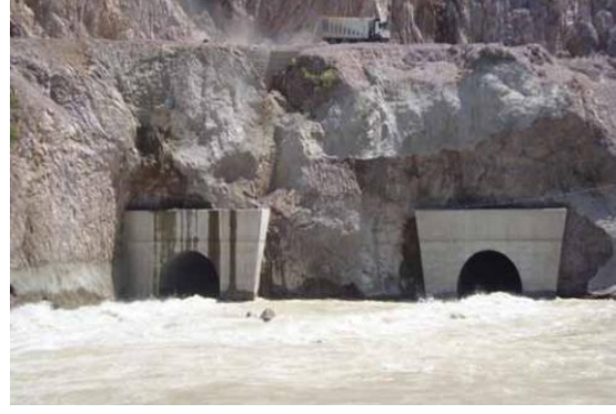
Şekil 1.13(b). Feke Barajı deriv. tüneli (Adana)
