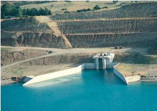
Şekil 1.10. Su alma yapısı örnekleri
