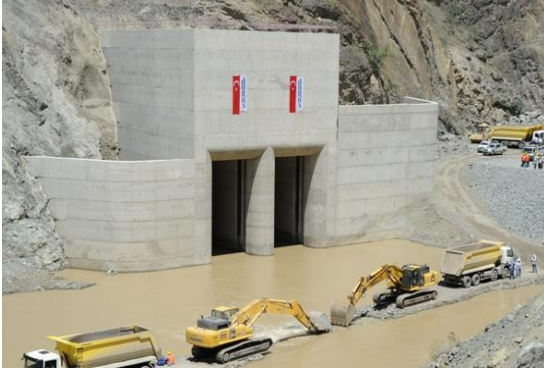
Şekil 1.13(a). Artvin Barajı deriv. tüneli
