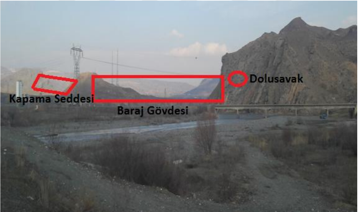
Şekil 2.9. Tuzluca Barajı aks yeri
