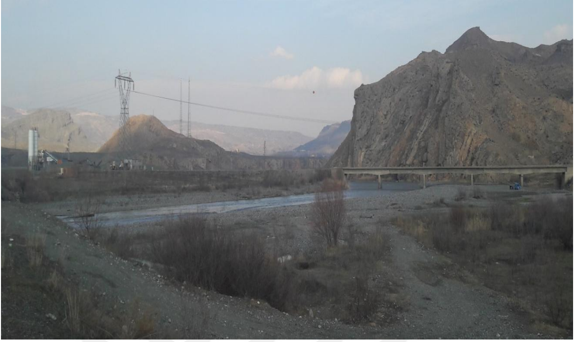
Şekil 2.8. Tuzluca Barajı aks yeri
