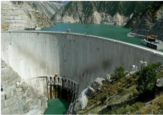
Şekil 1.8(a). Deriner Barajı gövdesi (Artvin)
