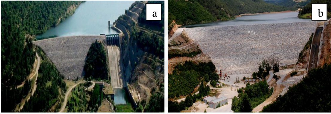
Şekil 1.24. Dolgu baraj örnekleri; Yenice Gönen (a) (Balıkesir) ve Nilüfer (b) (Bursa) Barajları
