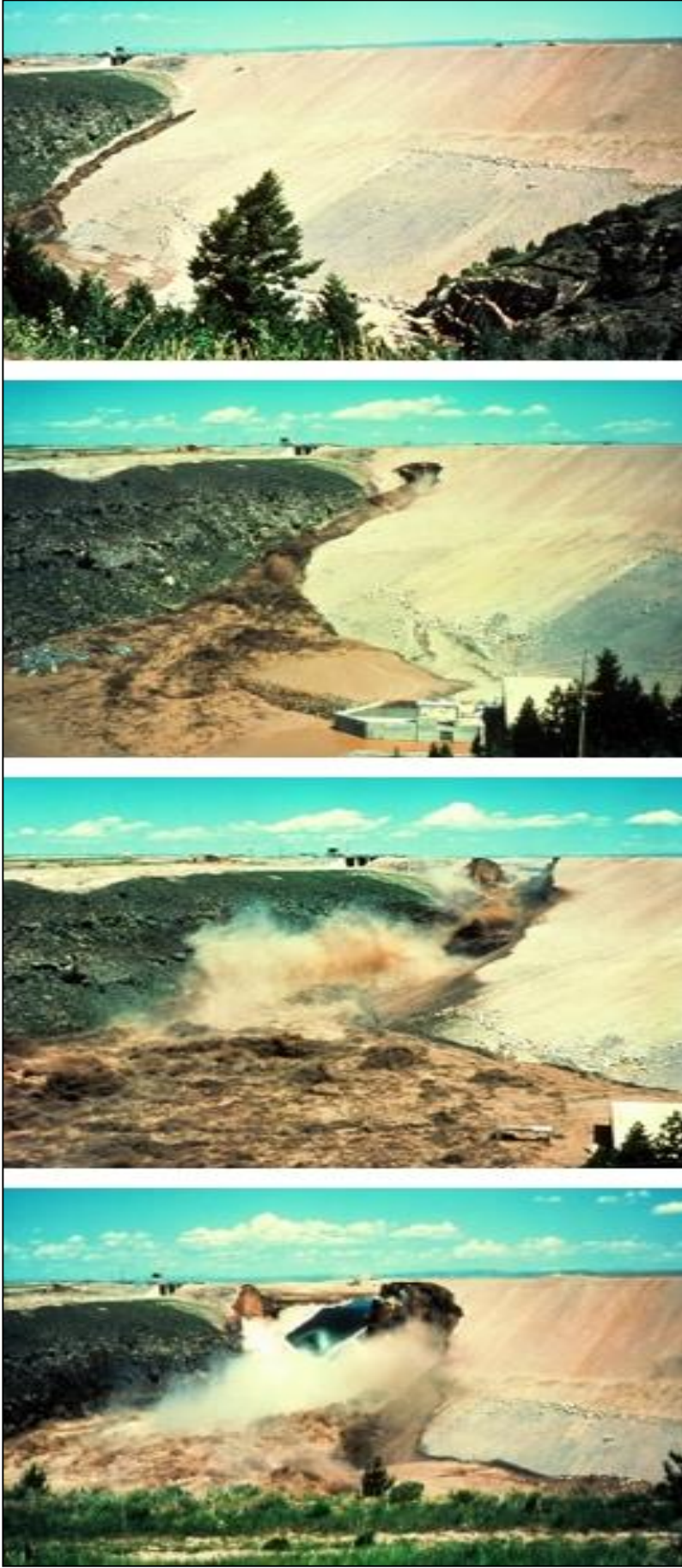
Şekil 6. Teton Barajı yıkılma aşamaları (URL-3, 2022).
