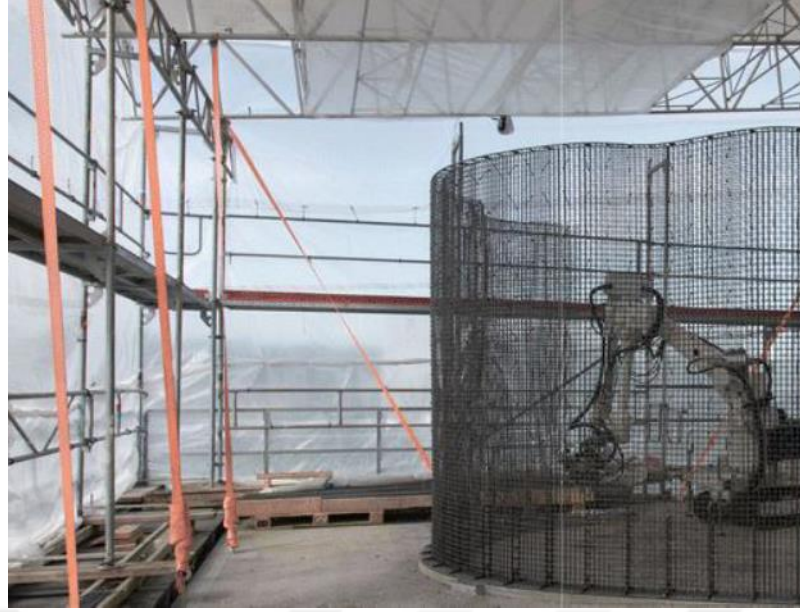
Şekil 2.5 3B Yazıcı ile İmalatta Donatı Uygulama Örneği (Uygunoğlu vd., 2019.)
