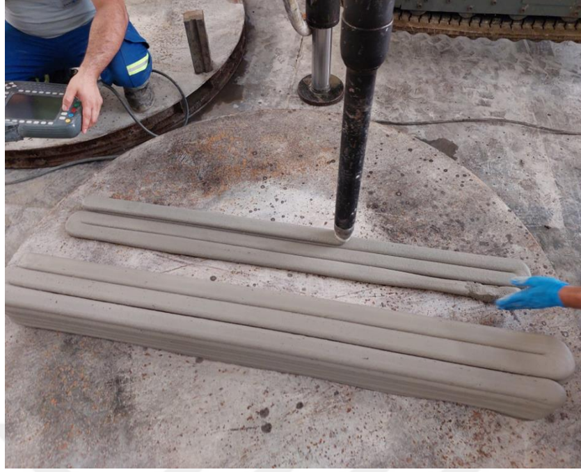
Şekil 3.14 3B Yazıcı ile Beton Basım İşlemi
