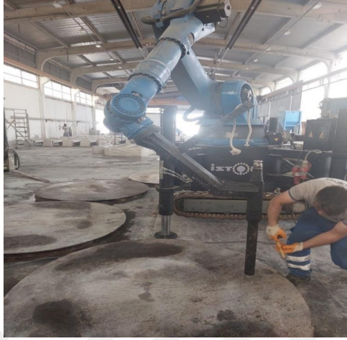
Şekil 3.9 Çalışmada Kullanılan 3B Beton Yazıcısı
