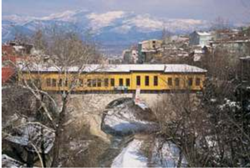
Şekil 3.3.1 Arastalı Köprü (ATLAS, 2005)
