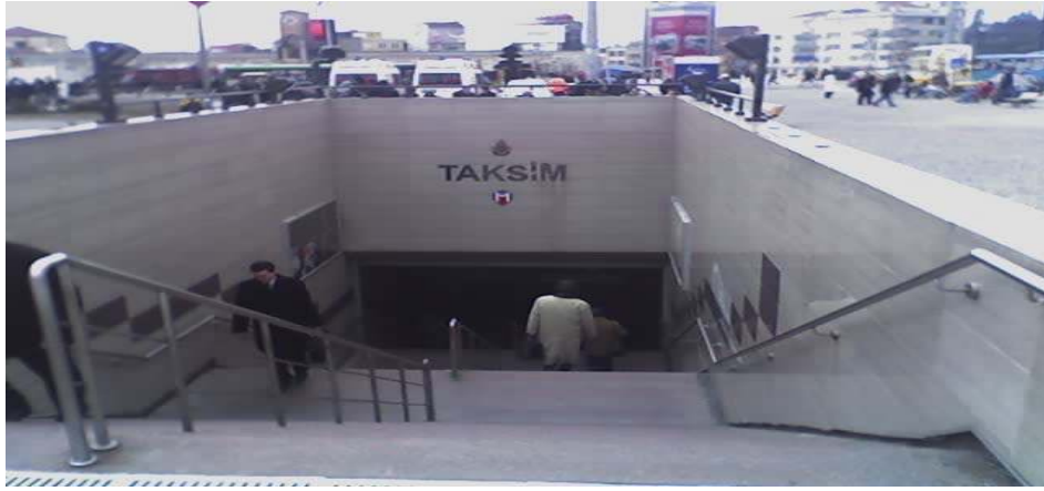
Şekil 3.1.d İstanbul Metrosu Taksim girişi 2007
