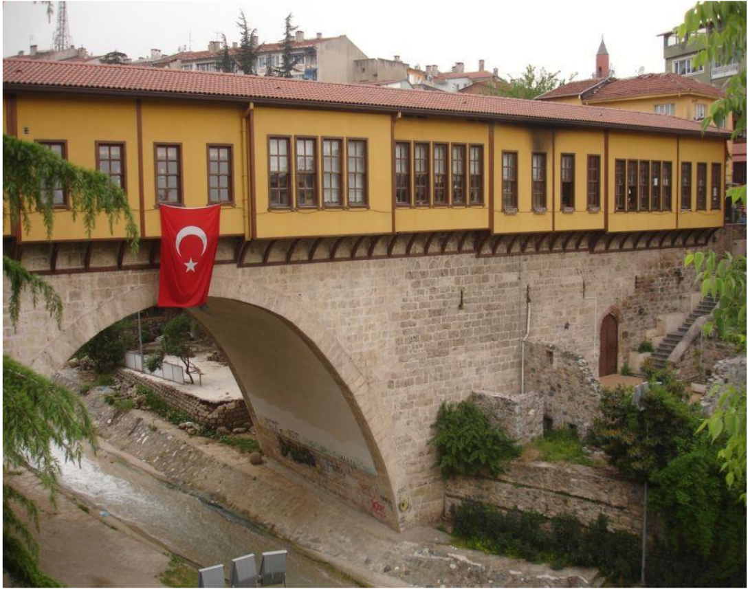
Şekil 1.4. Arastalı Köprü (ATLAS 2005)
