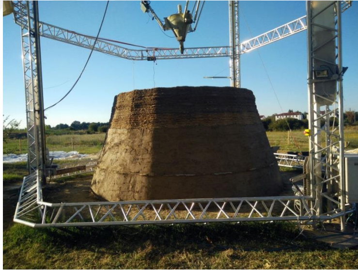
Şekil 97. İtalyan tasarım ekibi WASP'ın geliştirdiği 12 metrelik üç boyutlu yazıcı ile üretilen ev prototipi.
