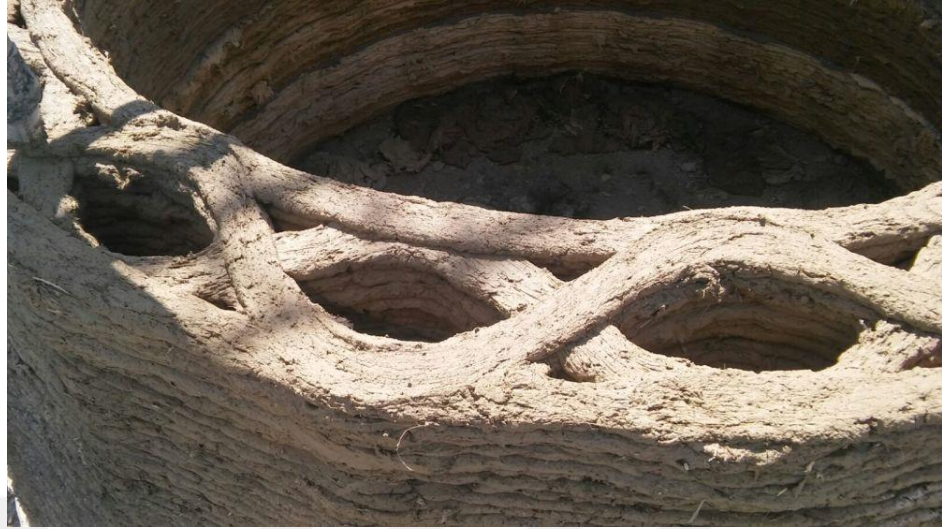
Şekil 96. İtalyan tasarım ekibi WASP'ın geliştirdiği 12 metrelik üç boyutlu yazıcı ile üretilen bir duvar örüntüsü
