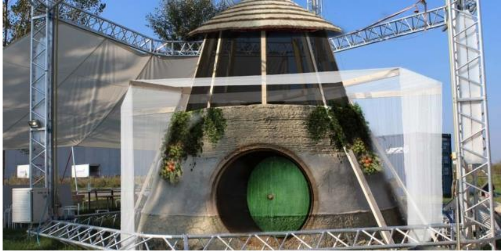
Şekil 98. İtalyan tasarım ekibi WASP'ın geliştirdiği 12 metrelik üç boyutlu yazıcı ile üretilen tamamlanmış ev prototipi.
