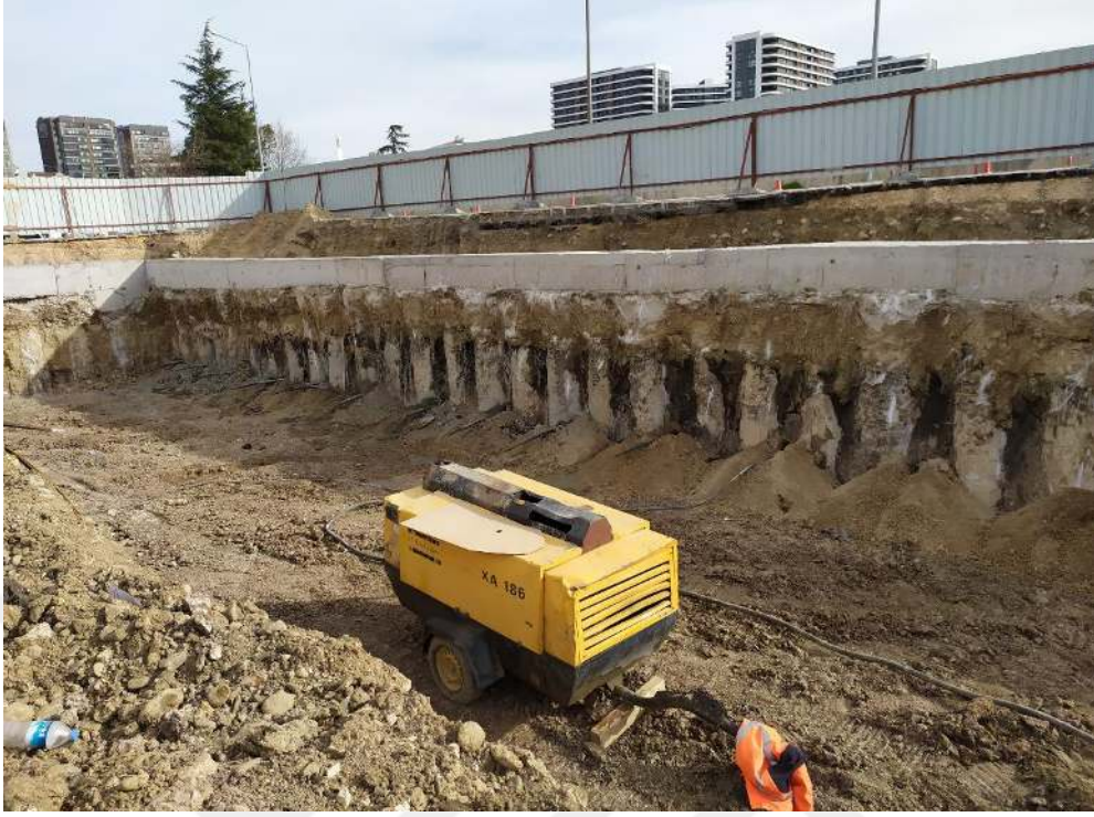
Şekil 2.15 Sahada Ankraj Uygulaması
