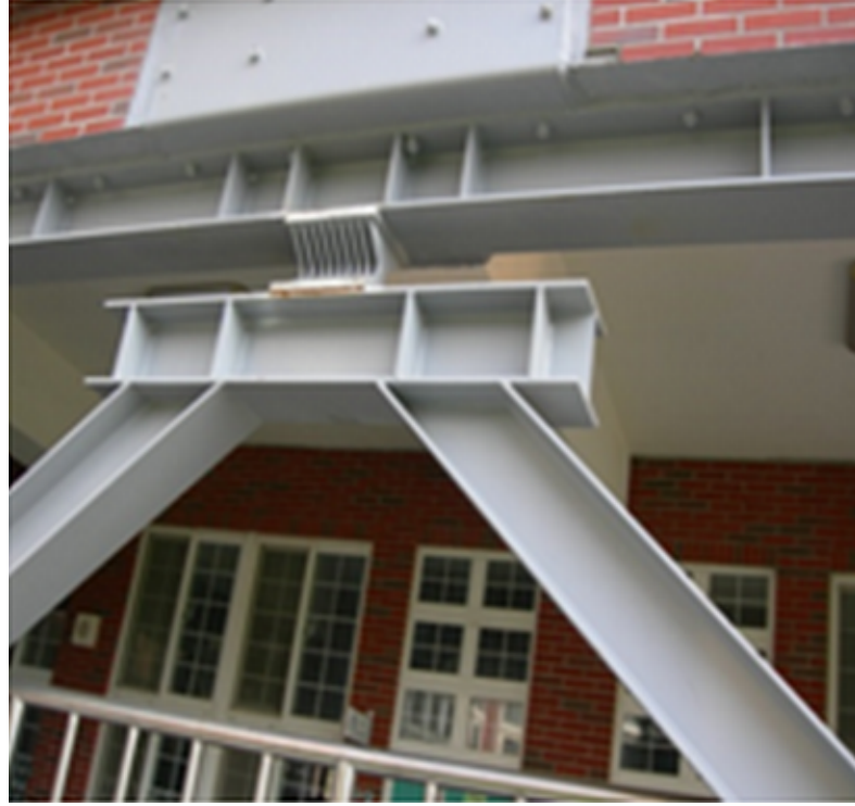
Şekil 1.3 : Deplasman Bağımlı Sönümleyici
