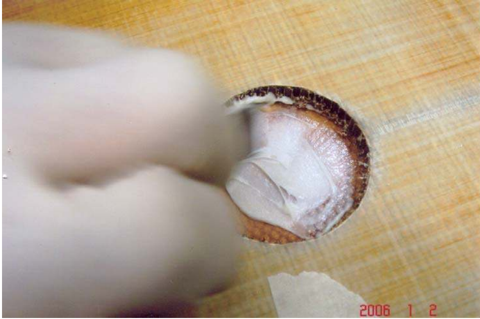
Şekil 7.64 Dolgu yapıştırma maddesi karıştırılarak tamir bölgesine sürüldü
