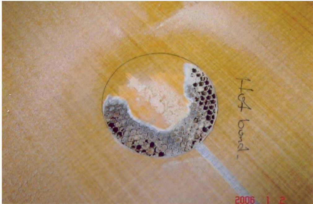
Şekil 7.74 Hasarlı bölge diğer bölgelere zarar vermeden çıkarıldı. Hasarsız alt tabaka yapı bırakıldı
