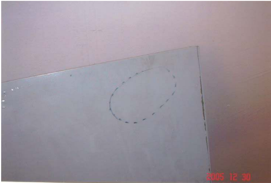
Şekil 7.44 Kaba hatlarıyla hata tespit edilen bölgenin işaretlenmesi
