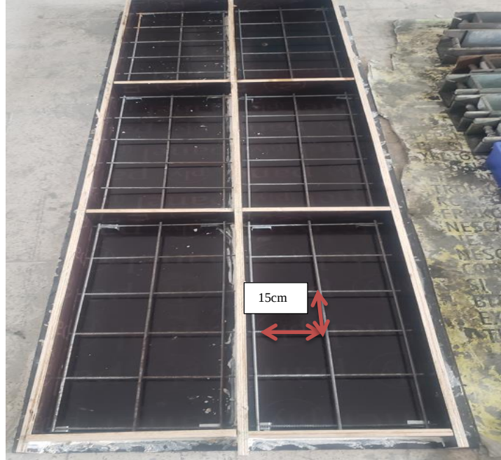
Resim 3.9 Duvar panel kalıpları (800x340x100 mm).
