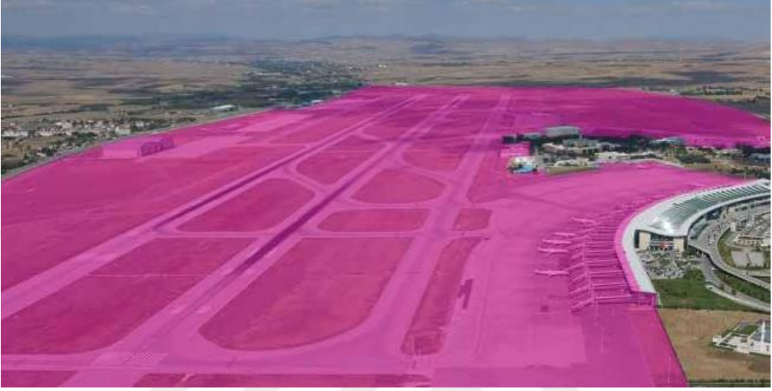
Görsel 2.13. Hava tarafı (Pist, apron, taksi yolları) (DHMI ders notu, 2021)
