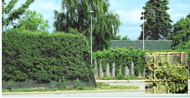
Görsel 4.18. Destekli bio-bariyer açılı duvar uygulaması (Bendtsen, 2009)
