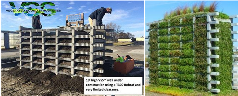
Görsel 4.27. Prekast yığın bio-bariyer ürünü (Vegetated Sound Structures)
