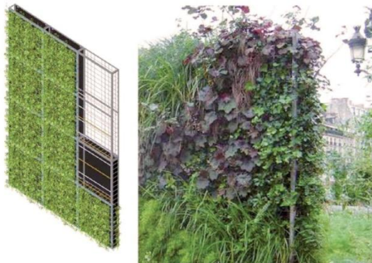
Görsel 4.19. Destekli bio-bariyer dikey duvar uygulaması (HOSANNA, 2009)
