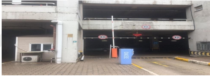
Şekil 5- 15: Bandırma Belediye Altı Katlı Otopark
