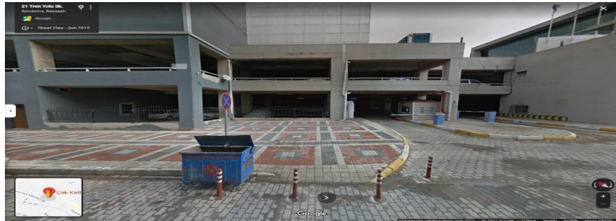
Şekil 5- 3:Bandırma Belediye Altı Katlı Otopark [282]
