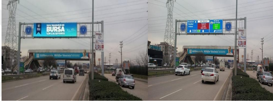
Şekil 3- 30:Değişken Ledli Mesaj Sistemi (VMS) [162]
