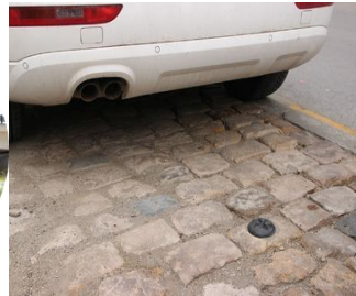
Şekil 3- 45: Kablosuz Park Sensörü
