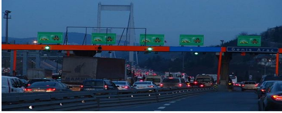
Şekil 3- 102: Fatih Sultan Mehmet Köprüsü Geçiş Sistemleri [257]
