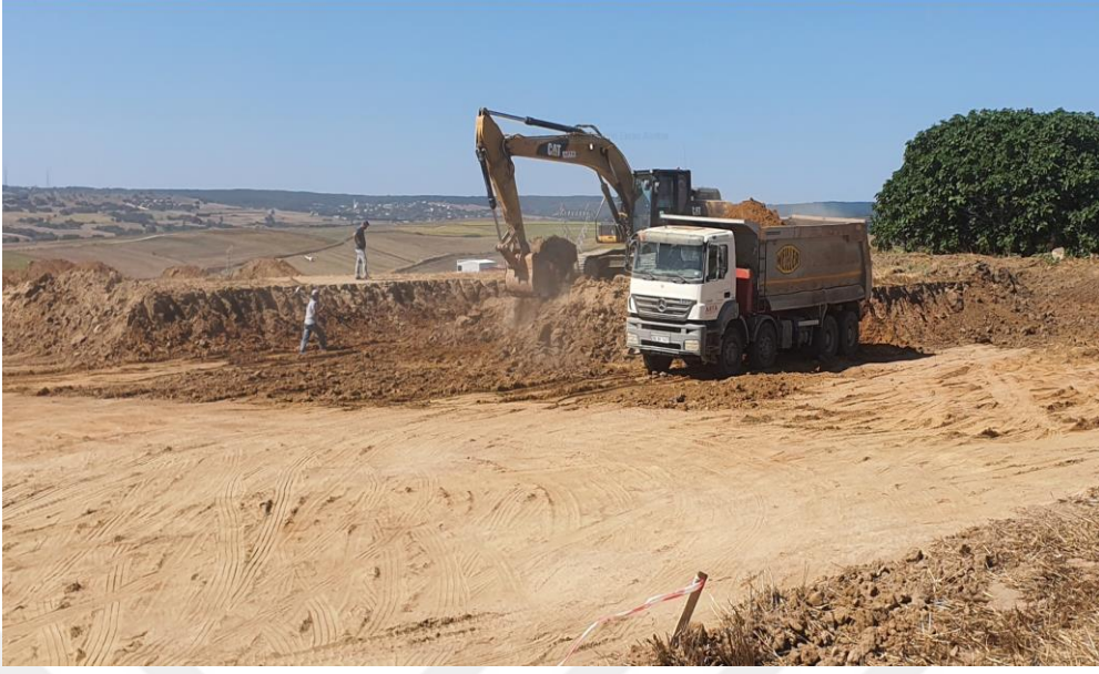
Şekil 31. Sahada kazı işlemi
