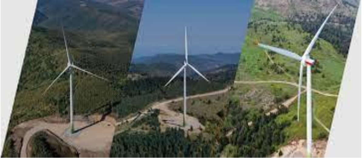
Şekil 22. Rüzgar enerjisi santrali
