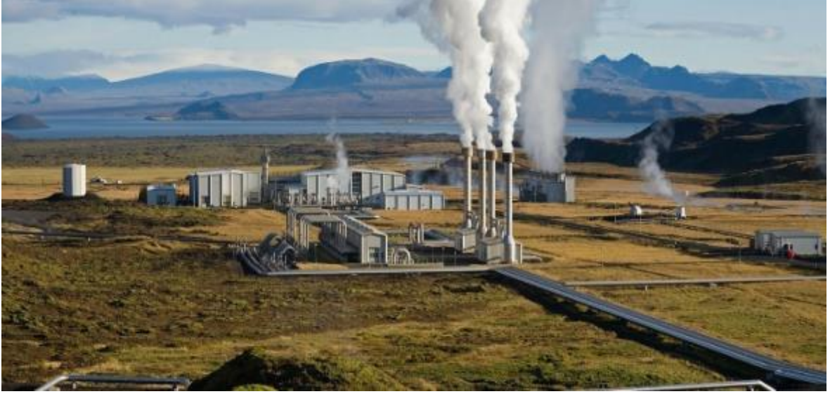
Şekil 19. Kurulumu tamamlanmış jeotermal santral
