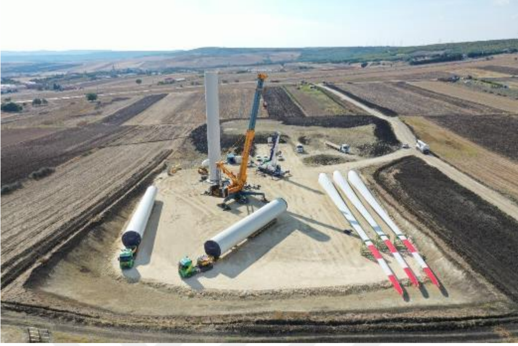
Şekil 33. Sahada tesviye ve kot tesisi
