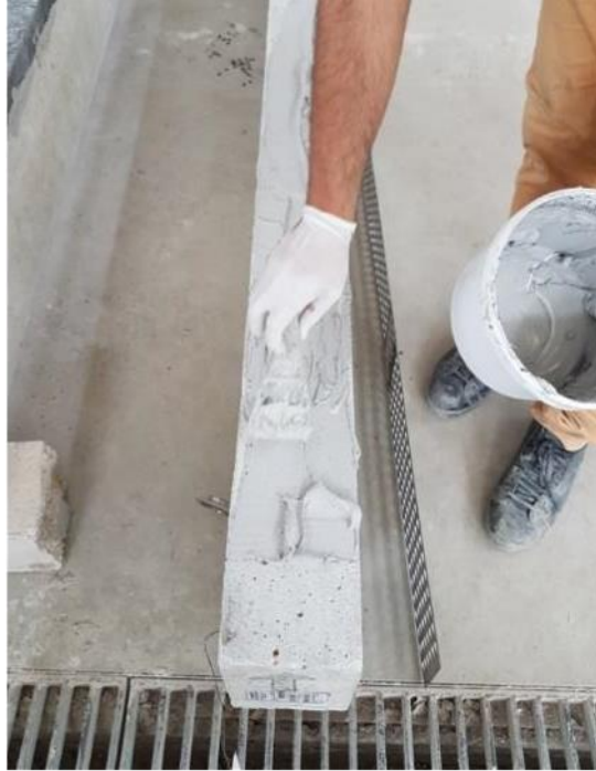
Şekil 3.9 Sikadur 31 epoksinin betonarme kirişe spatula yardımıyla sürülmesi(Kişisel arşiv, 2018)
