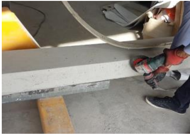
Şekil 3.7 Beton yüzeyinin hazırlanması(Kişisel arşiv, 2018)
