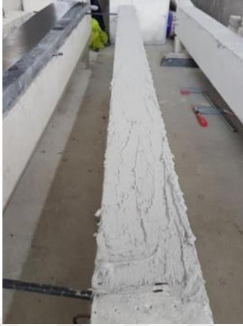
Şekil 3.10 Sikadur 31 epoksinin betonarme kirişe uygulanmış hali (Kişisel arşiv, 2018)
