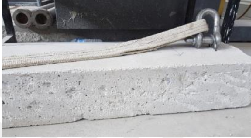
Şekil 3.8 Yüzey pürüzlendirmesi tamamlanmış betonarme kiriş elemanı(Kişisel arşiv, 2018)
