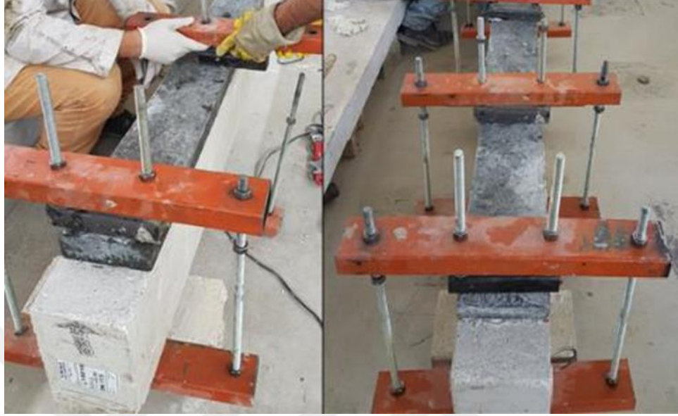
Şekil 3.12 UYPB lamine ile betonarme kirişin aparat ile sabitlenmesi (Kişisel arşiv, 2018)
