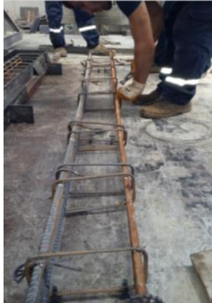
Şekil 3.4 Donatı düzenlemesi (Kişisel arşiv, 2018)
