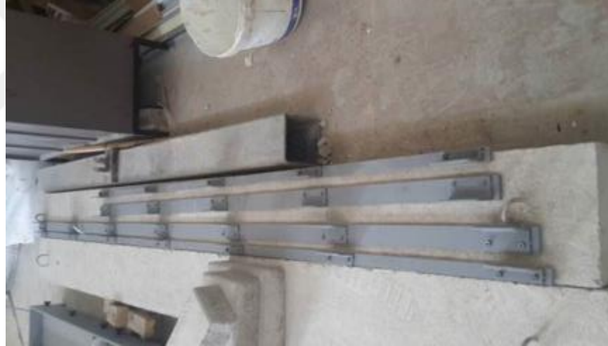
Şekil 2.21 Lamine kalıpları için yan yüzler(Kişisel arşiv, 2018)
