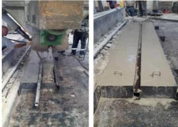
Şekil 3.6 Deney elemanları beton dökümü (Kişisel arşiv, 2018)
