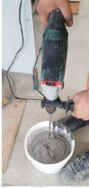
Şekil 3.2 Sikadur 31 epoksi bileşenlerinin karıştırılması (Kişisel arşiv, 2018)
