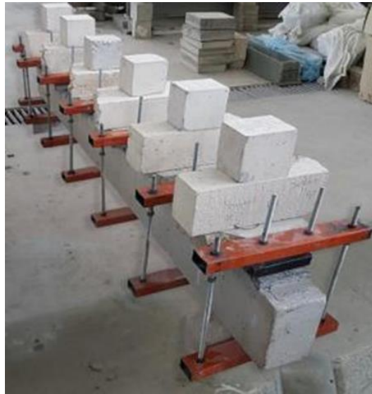
Şekil 3.13 UYPB lamine yapıştırılma işlemi (Kişisel arşiv, 2018)
