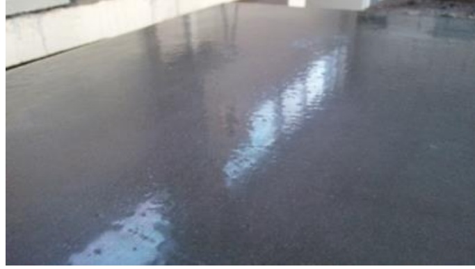
Şekil 4.10 Beton yüzeyinde gri renkli epoksi denemesi (Kişisel arşiv, 2017)
