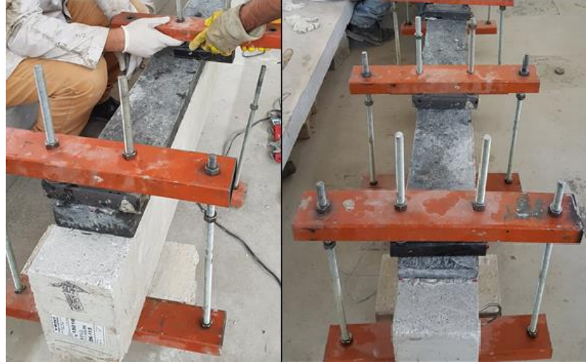
Şekil 2.27 UYPB plaka ile betonarme kirişin işkence aletiyle sabitlenmesi (Kişisel arşiv, 2016)
