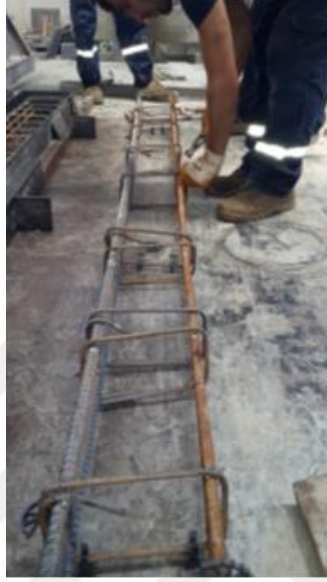
Şekil 2.7 Donatı düzenlemesi (Kişisel arşiv, 2016)
