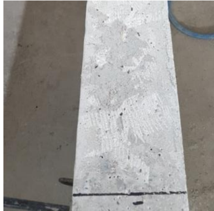
Şekil 2.24 Yüzeyi temizlenmiş betonarme kiriş elemanı (Kişisel arşiv, 2016)
