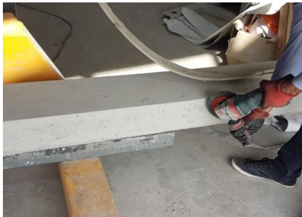
Şekil 2.22 Beton yüzeyinin temizlenmesi (Kişisel arşiv, 2016)
