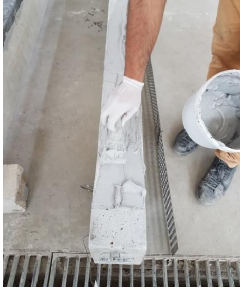
Şekil 2.25 Sikadur 31 epoksinin betonarme kirişe spatula yardımıyla sürülmesi (Kişisel arşiv, 2016)
