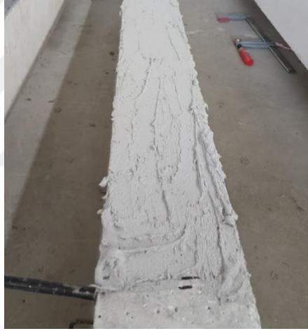
Şekil 2.26 Sikadur 31 epoksinin betonarme kirişe uygulanmış hali (Kişisel arşiv, 2016)
