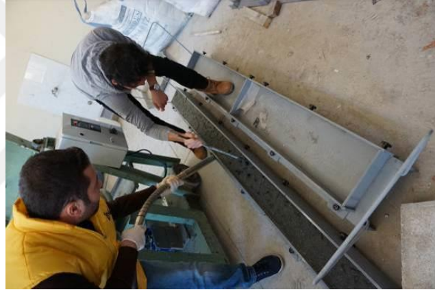
Şekil 2.20 Taze UYPB'nin şiş ve vibrasyon ile yerleştirilmesi (Kişisel arşiv, 2016)
