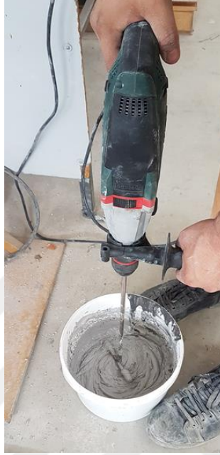
Şekil 2.23 Sikadur 31 epoksi bileşenlerinin karıştırılması (Kişisel arşiv, 2016)
