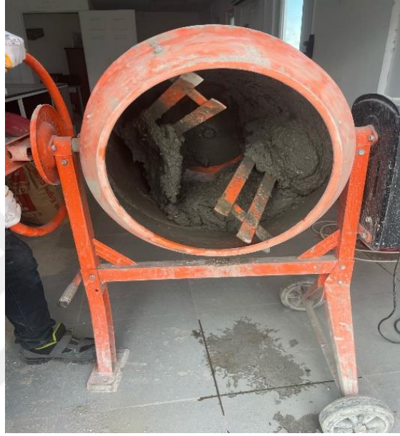
Şekil 4.12 UYPB beton mikserde üretimi
