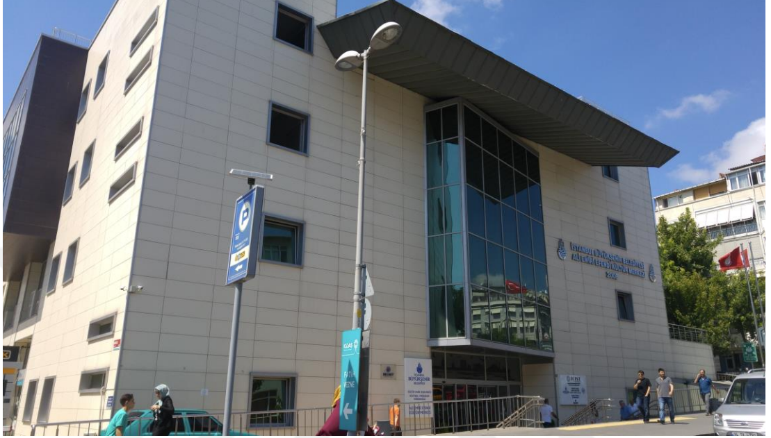
Fotoğraf 4.14. Türkiye - Kore Dostluk Ofis Binası, İstanbul Büyükşehir Belediyesi Ali Emiri Kùltür Merkezi, Fatih (21.07.2016, İstanbul)
