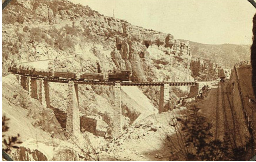
Şekil 2.35: Toroslarda Bağdat Demiryolu Viyadüğü.
