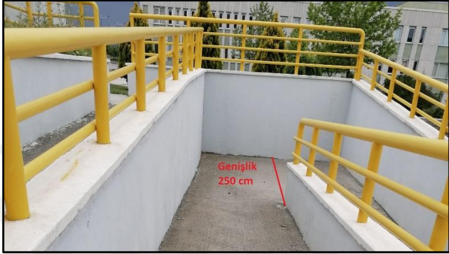
řekil 4.40 ÇAKÜ Uluyazı Kampüsü Ktphane binası rampası -2
