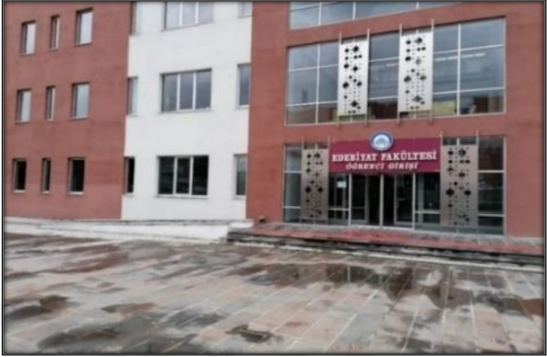
Şekil 4.7 ÇAKÜ Edebiyat Fakültesi binası öğrenci girişi
