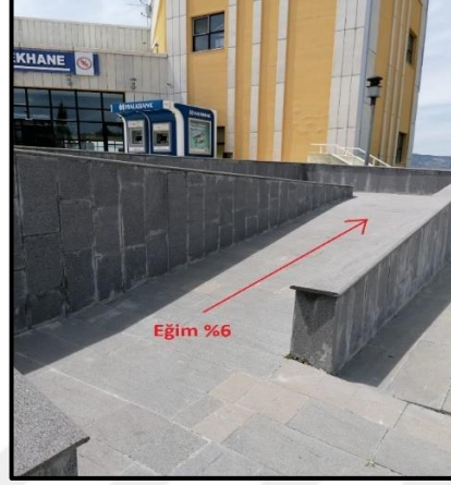
Şekil 4.42 ÇAKÜ Uluyazı Kampüsü Kütüphane binası rampası -4
