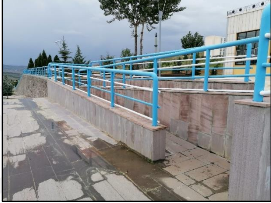
Şekil 4.44 ÇAKÜ Uluyazı Kampüsü Yemekhane binası rampası
