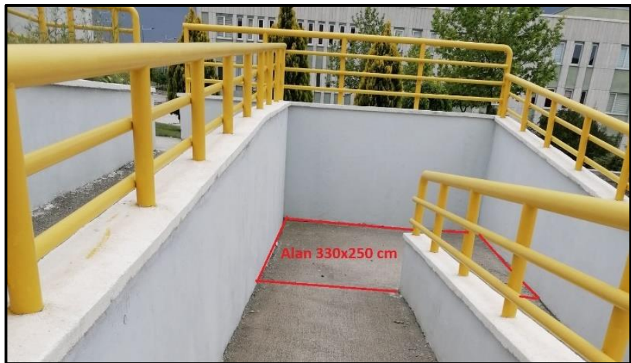
řekil 4.41 ÇAKÜ Uluyazı Kampüsü Ktphane binası rampası -3
