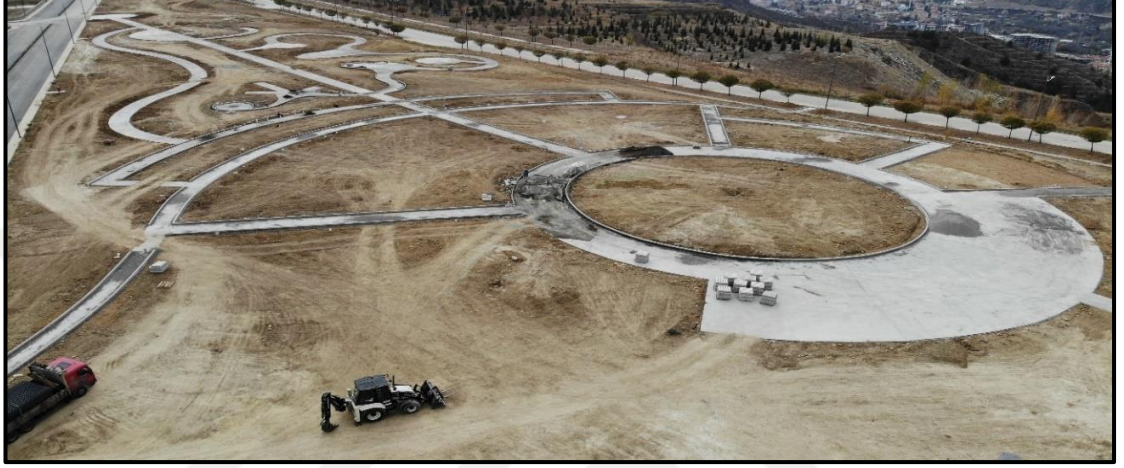
Şekil 4.4 Uluyazı Kampüsü Millet Bahçesi İnşaatı (ÇANKIRI KARATEKİN ÜNİVERSİTESİ 2023a)
