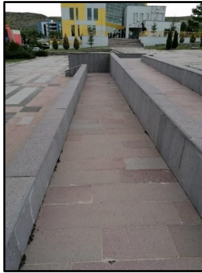
Şekil 4.43 ÇAKÜ Uluyazı Kampüsü ana yürüyüş yolu rampası
