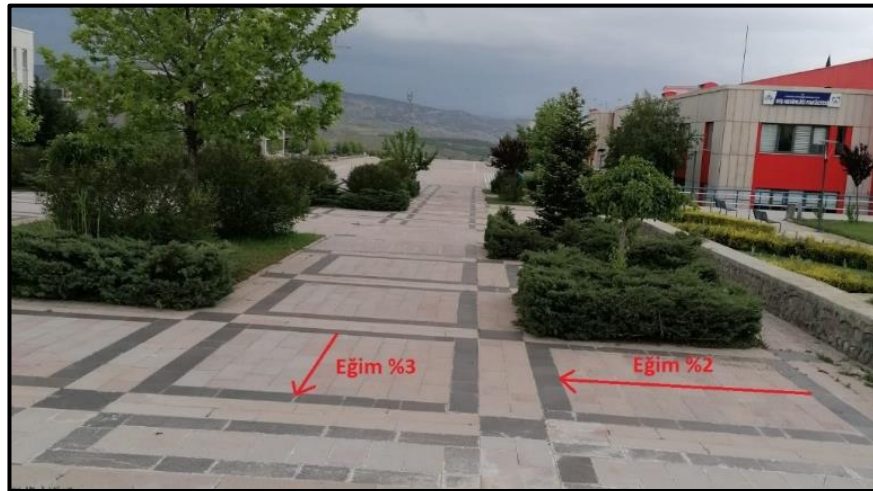
Şekil 4.21 ÇAKÜ Uluyazı Kampüsü ana yürüyüş yolu - 1
