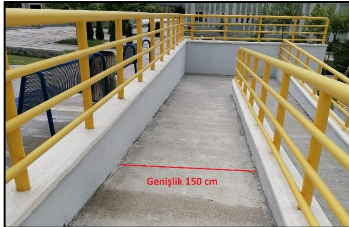
Şekil 4.39 ÇAKÜ Uluyazı Kampüsü Kütüphane binası rampası - 1
