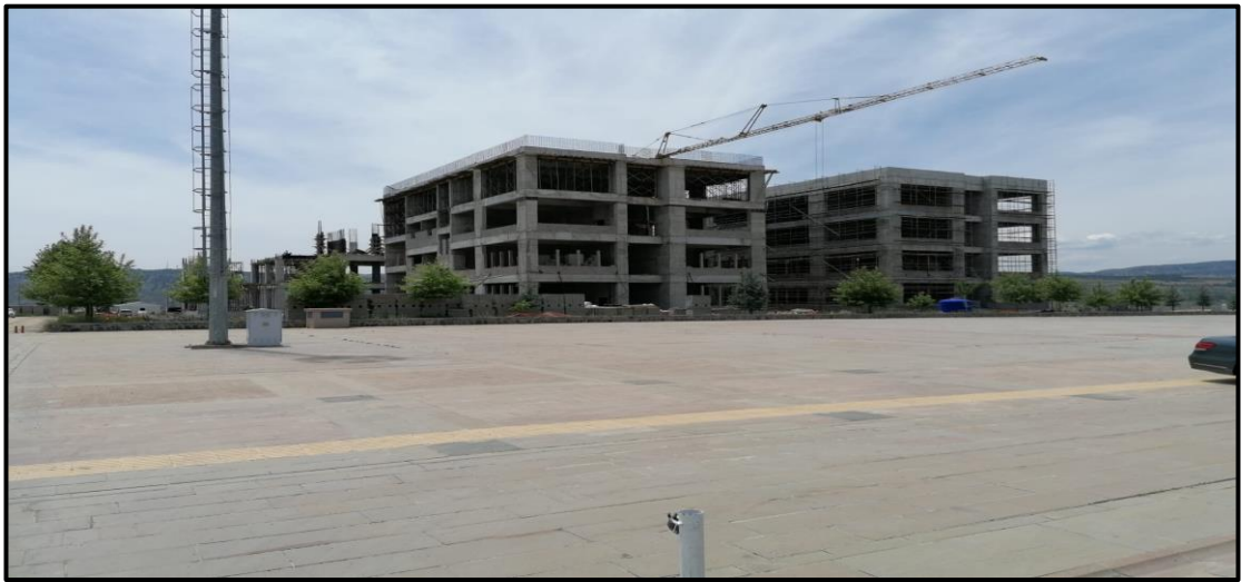
Şekil 4.5 Fakülte binası inşaatı (ÇANKIRI KARATEKİN ÜNİVERSİTESİ 2023a)
