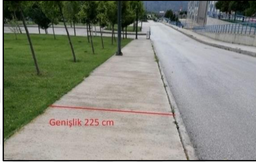
Şekil 4.23 ÇAKÜ Uluyazı Kampüsü açık spor alanlarının karşısındaki kaldırım
