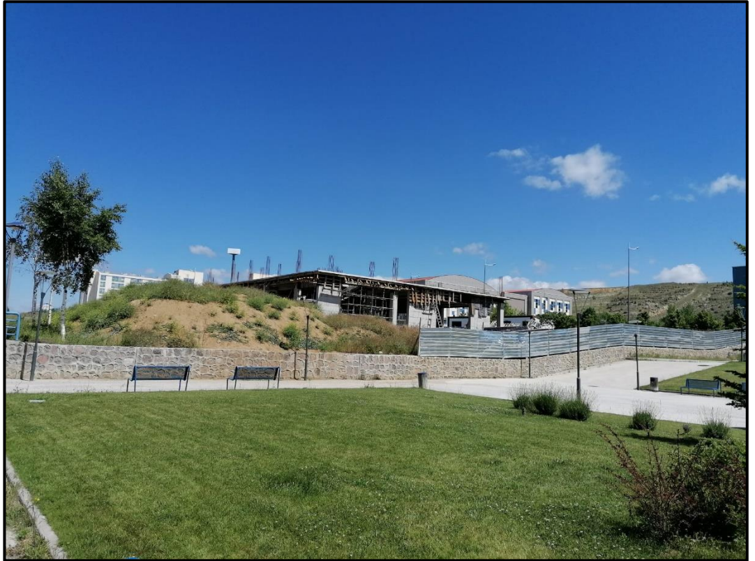
Şekil 4.3 Merkezi derslik binası inşaatı (ÇANKIRI KARATEKİN ÜNİVERSİTESİ 2023a)
