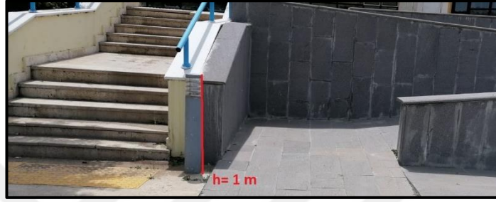
Şekil 4.64 ÇAKÜ Uluyazı Kampüsü Yemekhane binası alçak aydınlatma
