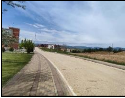
Orman Fakültesi Önü Taşıt Yolu
