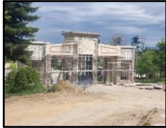
Yapımı Devam Eden İkincil Giriş Kapısı
