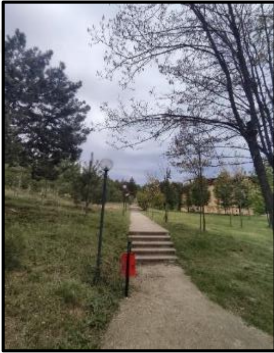
Levent Semizer Spor Salonu Yanı Alternatif Ulaşım Sağlayan Merdiven
