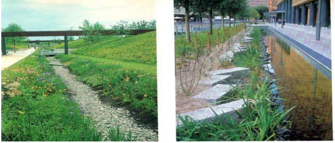
Şekil 38. Hendeklerde filtreleme amacıyla kullanılan zambaklar (Sert, 2013)
