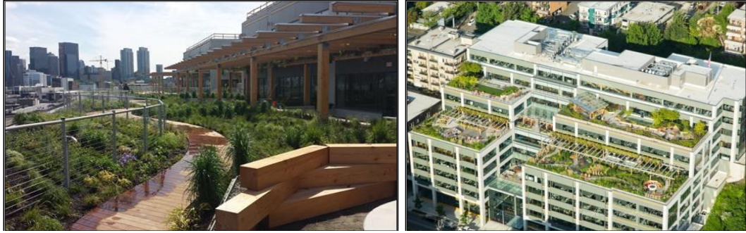
Şekil 34. Derin Yeşil Çatı Uygulaması, Facebook Seattle Binası (Sevimli, 2021)
