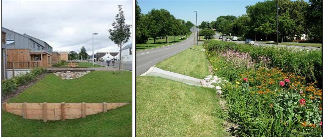
Şekil 39. Çimlendirilmiş ve Bitkisel Hendek Uygulaması (Sevimli, 2021)
