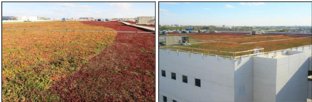
Şekil 33. Yüzeysel Yeşil Çatı Uygulaması, Chicago O'Hare Uluslararası Havaalanı (Sevimli, 2021)
