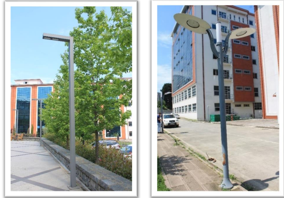
Şekil 27. Çalışma sınırları içinde yer alan sokak aydınlatma türleri.
