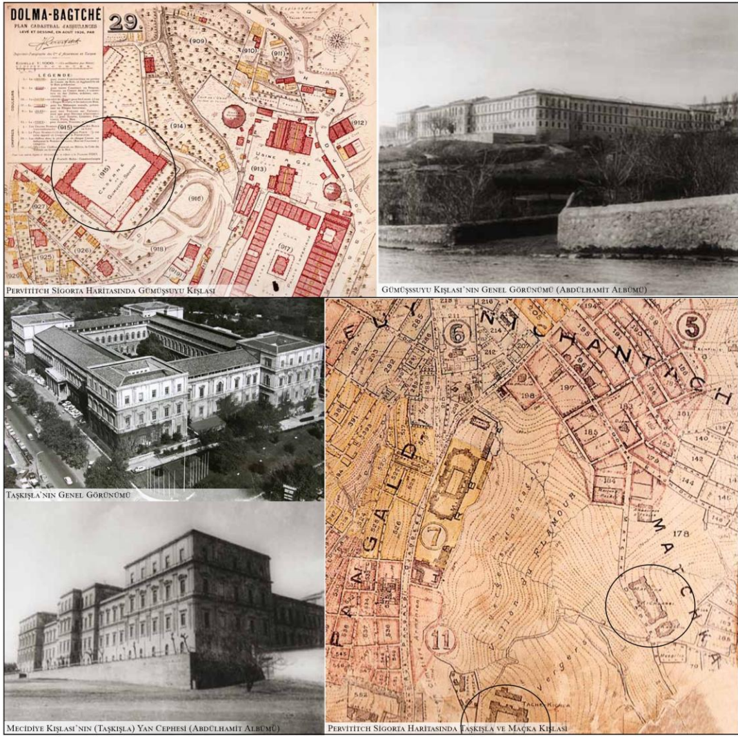
Şekil 4.24. Gümüşsuyu, Taşkılla ve Maçka Kışlarının konumları ve genel görünümeleri (Kaçar, Zorlu, vd., 2012)
