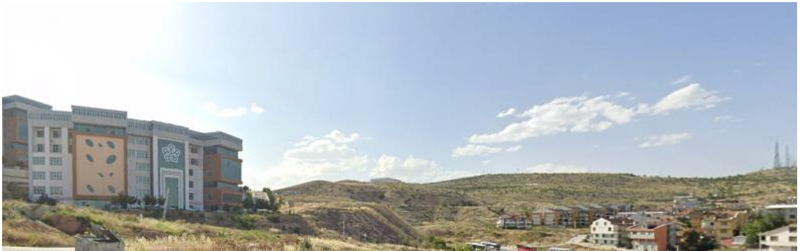
Şekil 5.117.: Necmettin Erbakan Üniversitesi Köyceğiz Kampüsü'nde yer alan ortak dersliklerin görünümü
