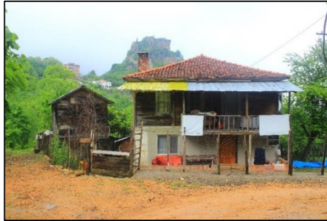
Fotoğraf 2.17. Güzelkale Mahallesiinde Karma Yapılı Bir Mesken Türü
