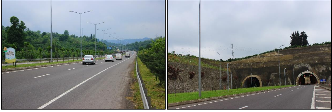
Fotoğraf 3.18. Ünye İlçesi Çevre Yolu ve Tüp Geçiş Tünelleri
