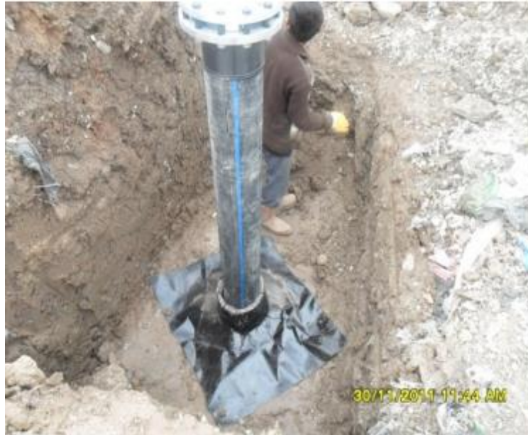
Şekil 4.8. Baca yerleşim düzeneği
