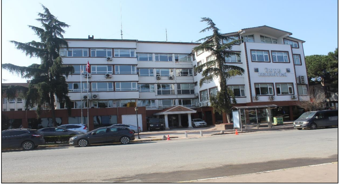
Şekil 3.1.1: Ünye Belediyesi hizmet binasından bir görünüm
