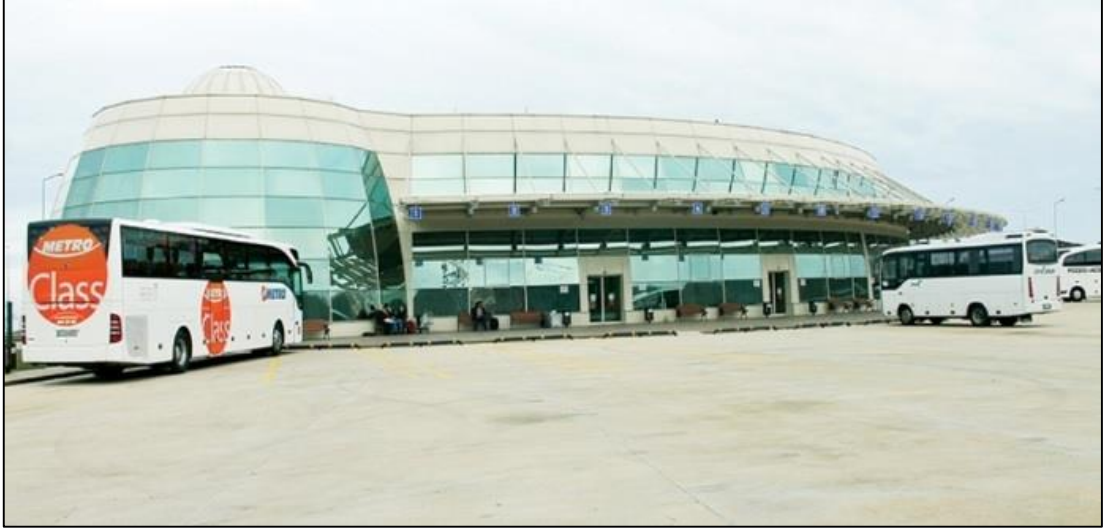
Şekil 3.5.2: Ünye Otobüs Terminali'nden bir görünüm
