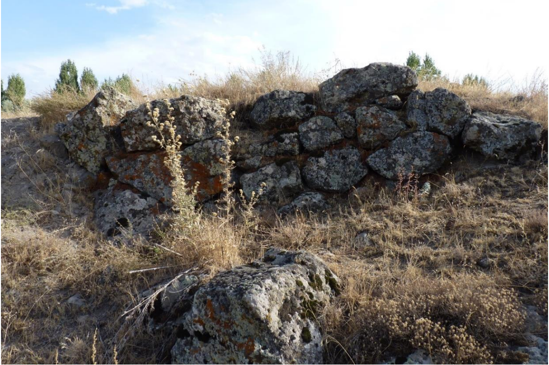
Resim 6. 51. Minua (Adalar) Kanalı'nın Destek Duvarı
