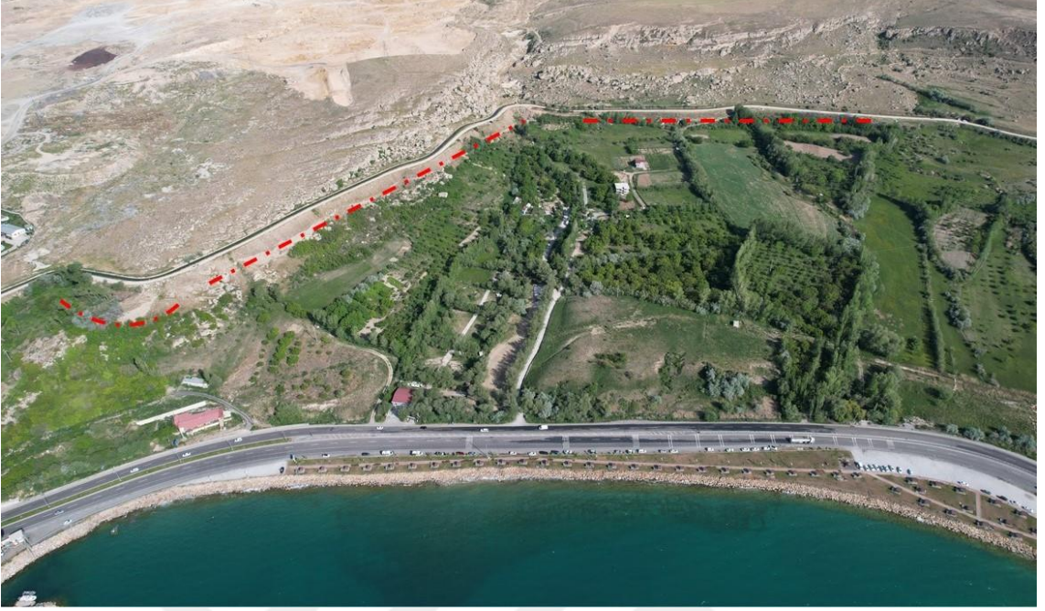
Resim 7. 1. Kadembas Mevkiinde Görülen Minua Kanalı ve Destek Duvarı Hattı (Hava Fotoğrafi)
