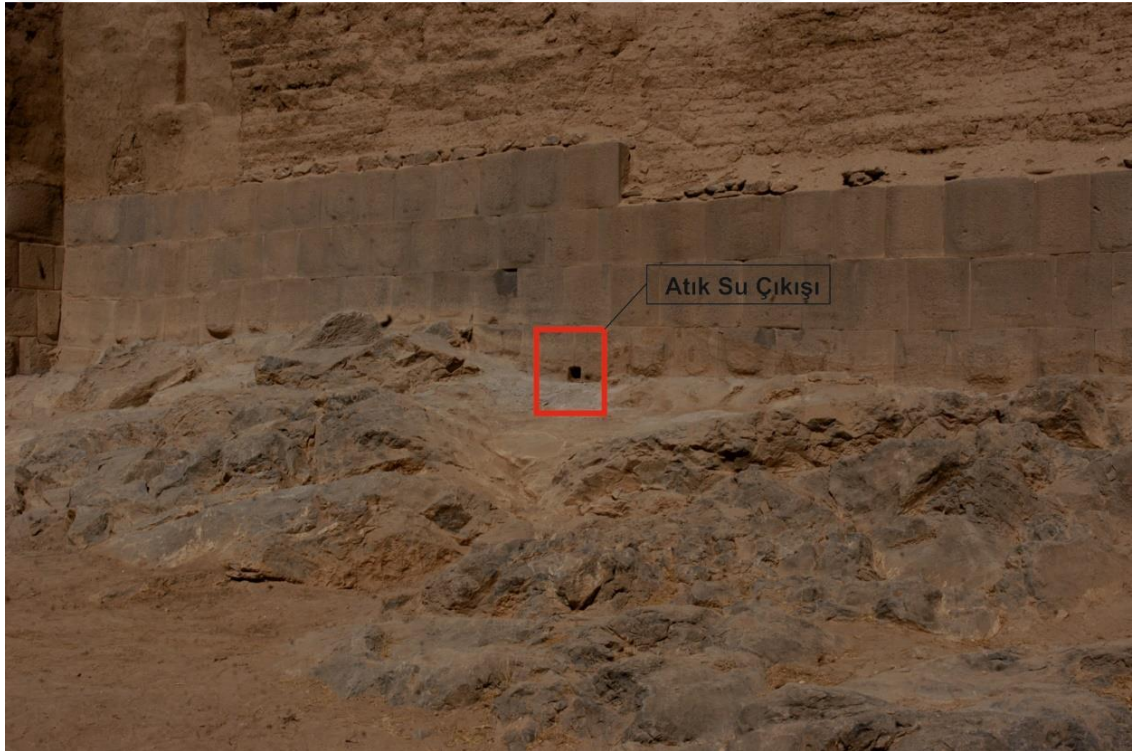
Resim 6. 9. Güney Sur Alanında Bulunan Drenaj Kanalı Tahliyesi (Caner, 2018: Res. 31)
