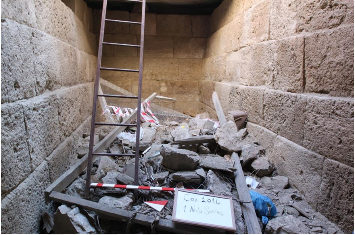
Resim 6. 27. Çavuştepe 1 No'lu Sarnıcın Kazı Öncesi Durumu (Kenan Işık 2014 Arşivinden)
