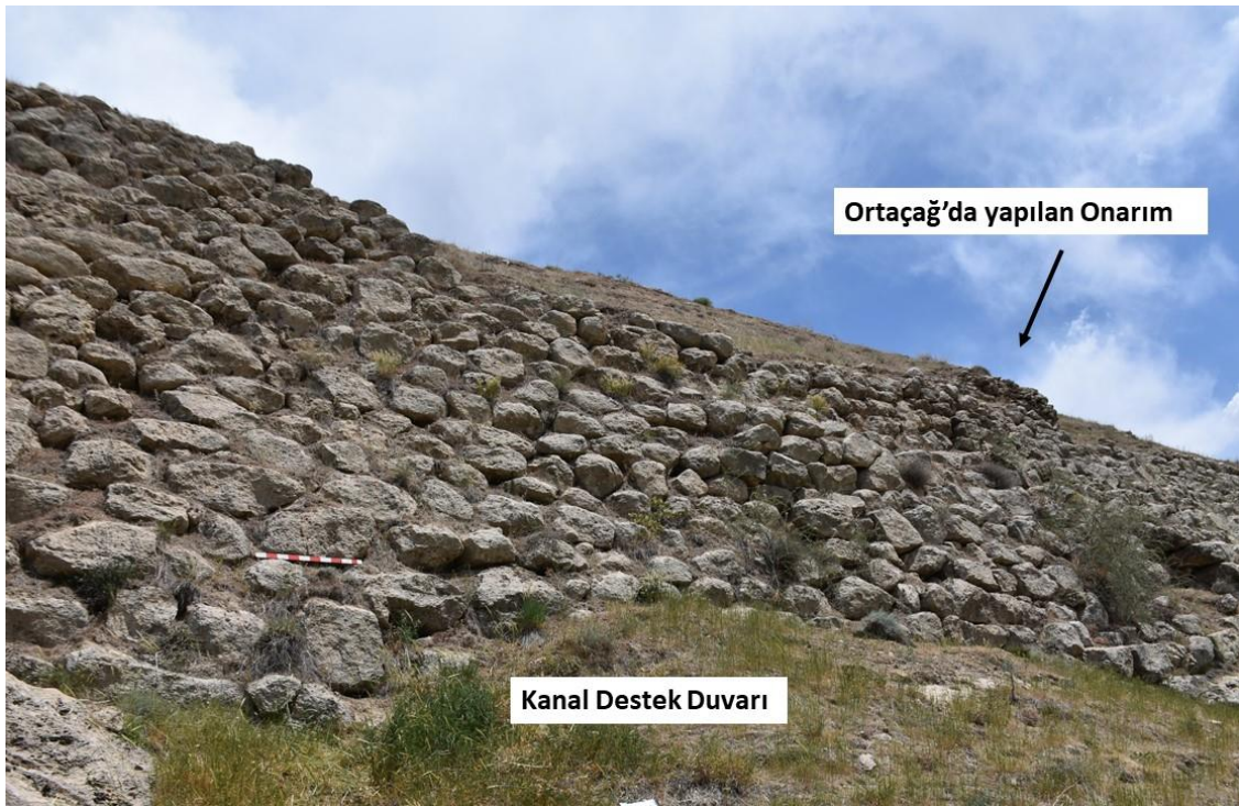
Resim 6. 46. Kanal Destek Duvarı ve Orta Çağ'da Yapılan Yenileme (Kadembas/Kadembastı)
