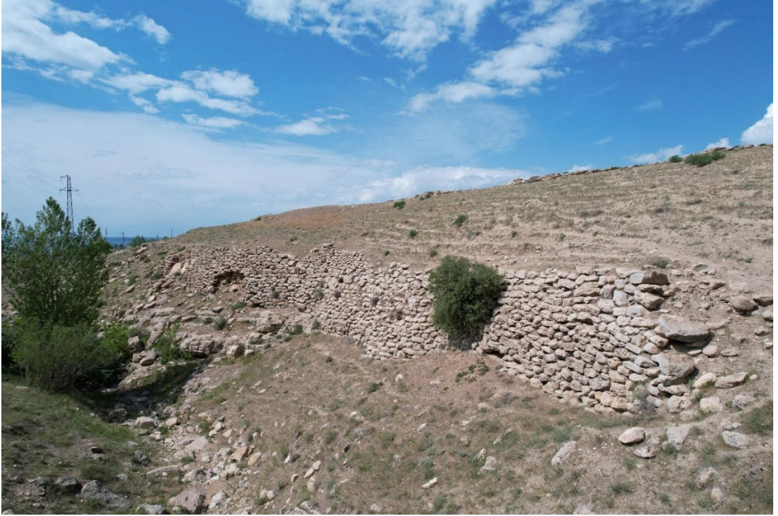
Resim 7. 2. Gülo Boğazı Destek Duvarları
