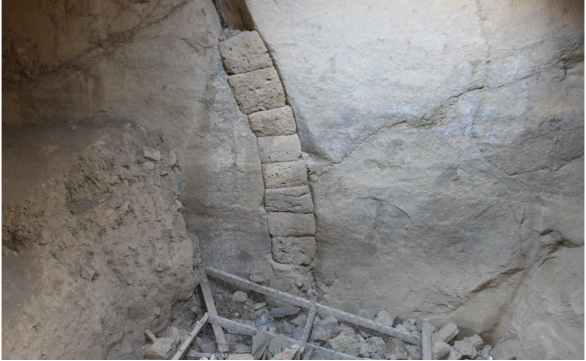
Resim 6. 28. 3 No'lu Sarnıçta Kaya Yarığının Taşlarla Örülmesi (Kenan Işık 2014 Arşivinden)
