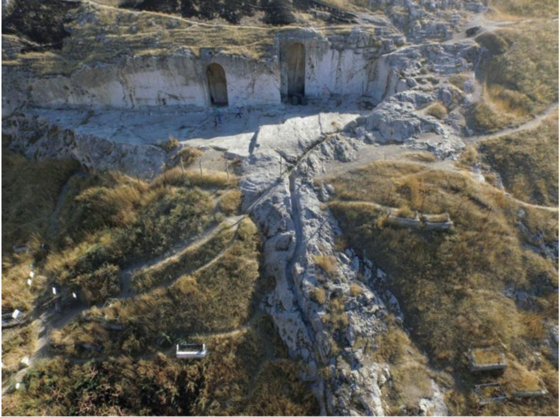
Resim 6. 15. Analıkız Alanı Genel Görünümü ve Drenaj Kanalı (Genç ve Konyar, 2019: Res. 2)
