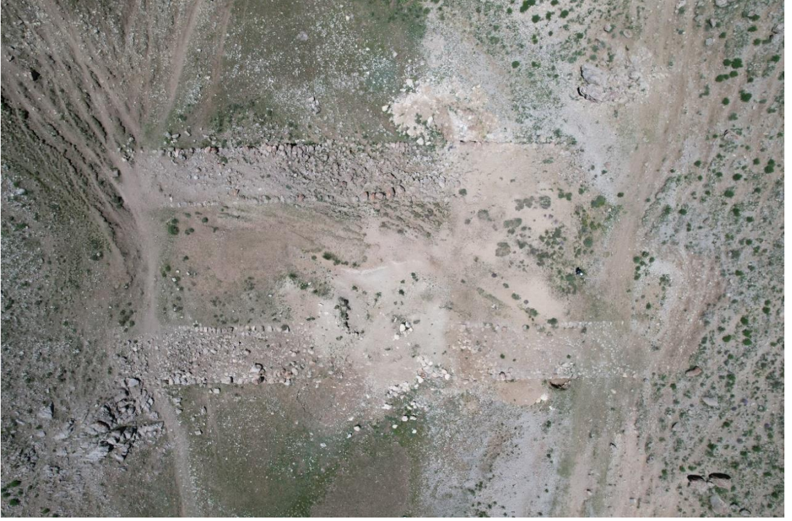
Resim 6. 67. Rusa Baraj Göletinin Batı Bendi (Hava Fotoğrafı)
