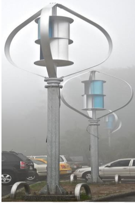
Şekil 2.5. Darrieus ve Savonius bütünüleşik tasarımı
