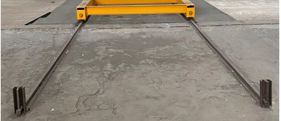
Şekil 4.13. Ray sistemi döşeme montajı
