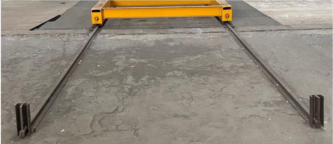
Şekil 4.13. Ray sistemi döşeme montajı
