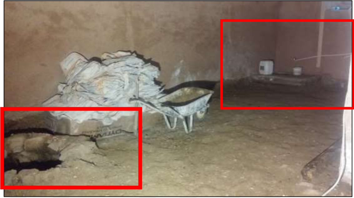
Şekil 8.4. 2013 yılı onarım sırasında tespit edilen kuyu ve hela taşı.
