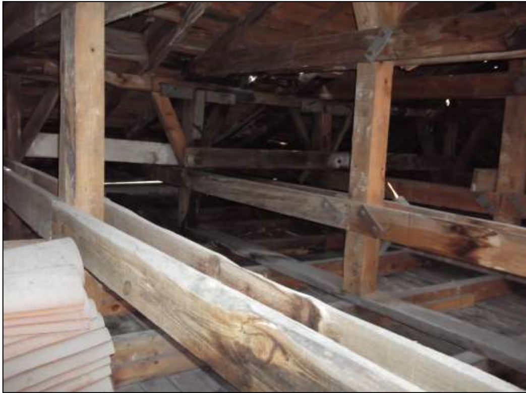
Şekil 8.5. 2013 yılı onarım sırasında tespit edilen çatı makasları.
