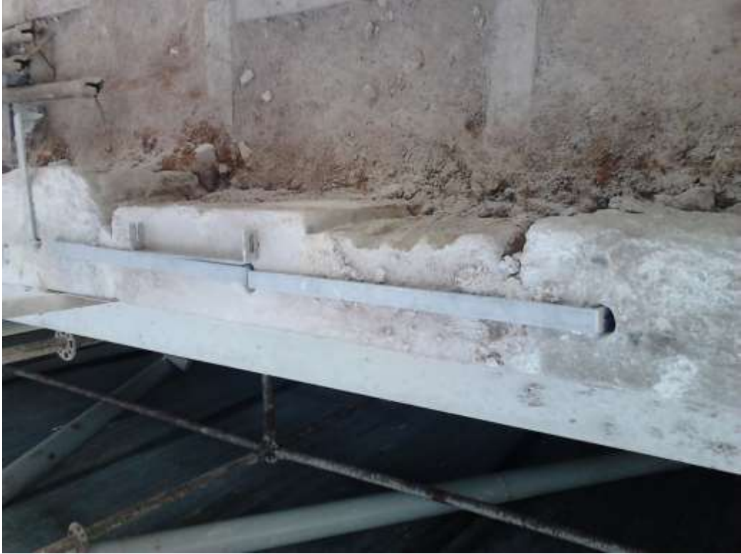
Şekil 8.11. 2013 yılı onarımı ön cephe kenet uygulaması.
