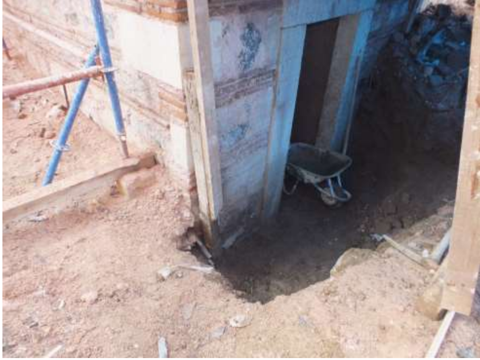
Şekil 8.30. Uygulama sırasında sol yan cephede yapılan kazı ve çevre düzenlemesi.
