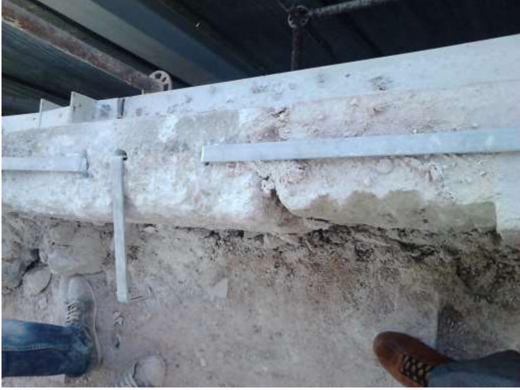
Şekil 8.10. 2013 yılı onarımı ön cephe kenet uygulaması.
