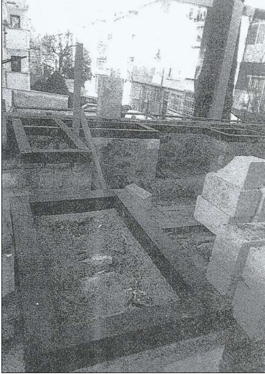
Şekil 8.7. 2013 yılı onarım sırasında uygulanan ahşap hatıllar.
