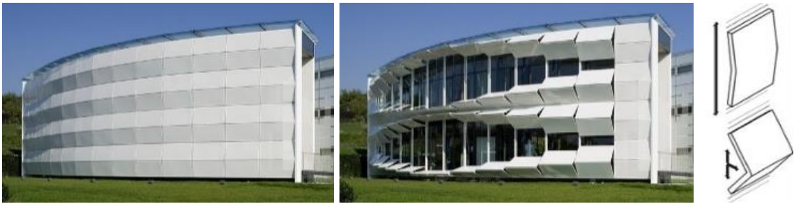
Görsel 3.3. Kiefer Technic Showroom; cephinin genel görünümü ve cephinin çalışma prensibi ((http-8), Moloney, 2011)
