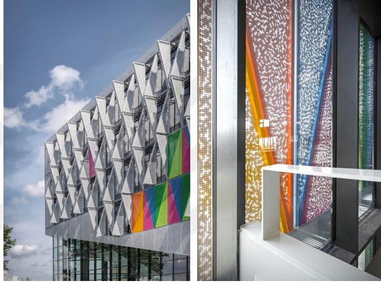
Görsel 5.5. SDU Kolding Cephesi (http-38)
