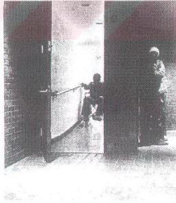
Resim 4. 2. Joseph E. Cole Rekreasyon Merkezi'nde Koridor duvarlarına yerleştirilen tutunma bantları (Anonim, 1978, s:74)
