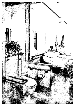
Resim 5. 12. Mitaka'daki Yaşamı Koruma Konutu'nda yatak odası ile banyo arasındaki vinç düzeneği (Canada Mortgage And Housing Corporation(CMHC), 1992, s:93)
