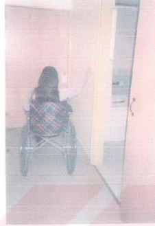
Resim 4. 15. Kolay erişilebilir elektrik düğmeleri
