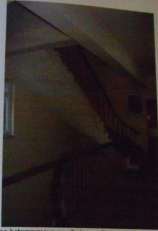
Sonradan betomarmeye çevrilmiş merdiven ana merdiven (A Blok)
